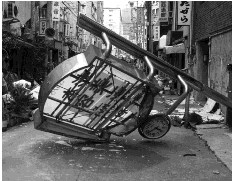
شکل ۱- خرابی در یک تابلو تبلیغاتی در حین زلزله کوبه (۱۹۹۵)
