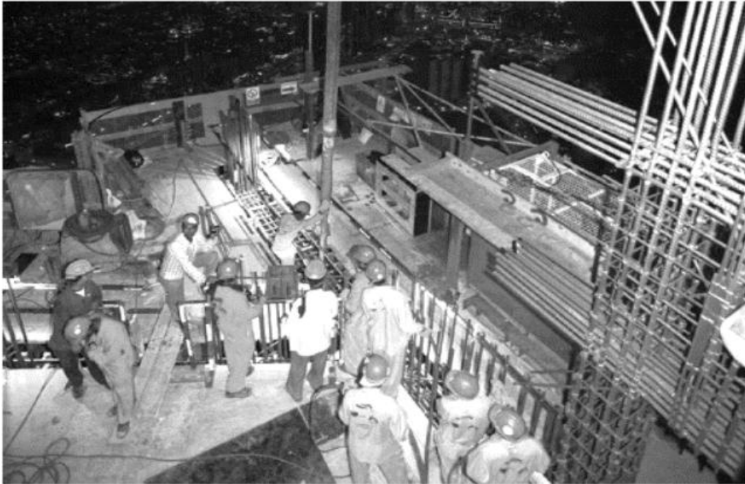
شبکه های متراکم آرماتور در برج خلیفه
