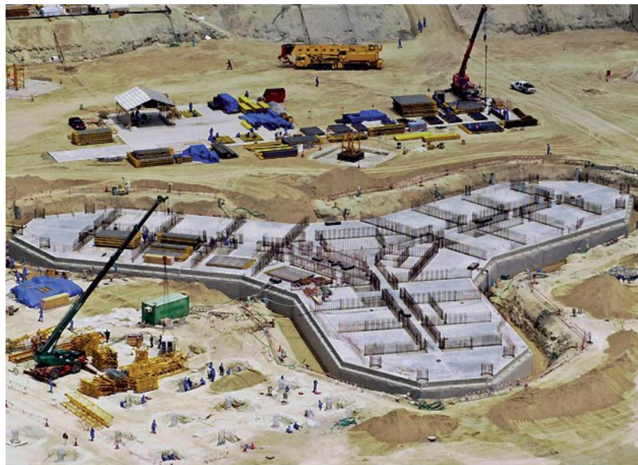
فونداسیون برج خلیفه
