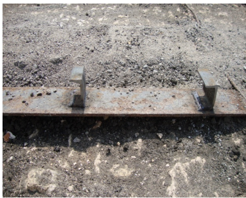
ب. اجرای برشگیر بر روی تیرهای موجود
