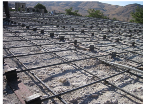
ج. آرماتورگذاری سقف
