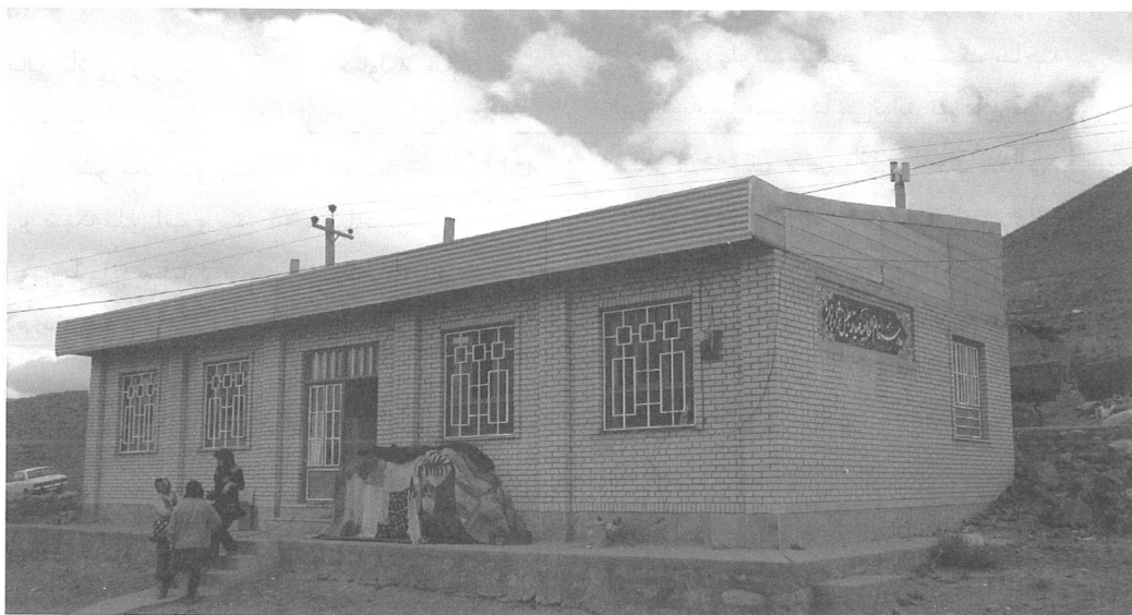
شکل ۴- ساختمان بنایی آجری مدرسه روستای چوبانلار بدون آسیب‌های سازه‌ای و غیرسازه‌ای
