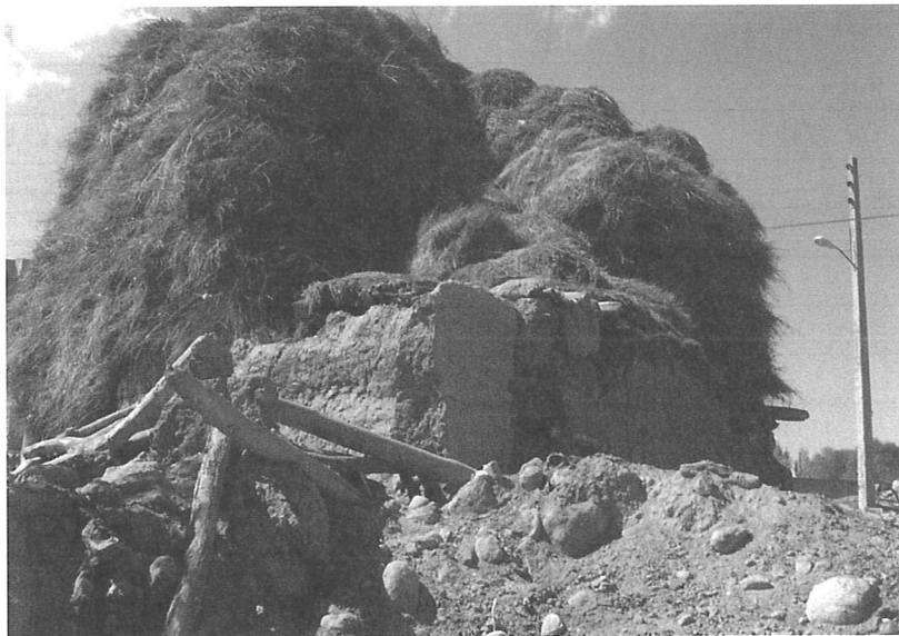
شکل ۴- سربار دائمی بر روی سقف مسکن خشت و گلی
