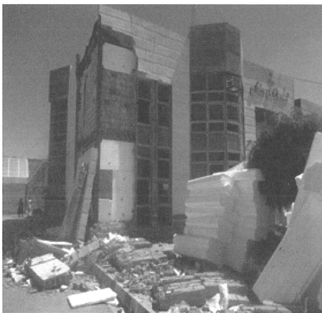
شکل ۳- خرابی و فروریزش بخشی از نمای سنگی ساختمان فرمانداری ورزقان
