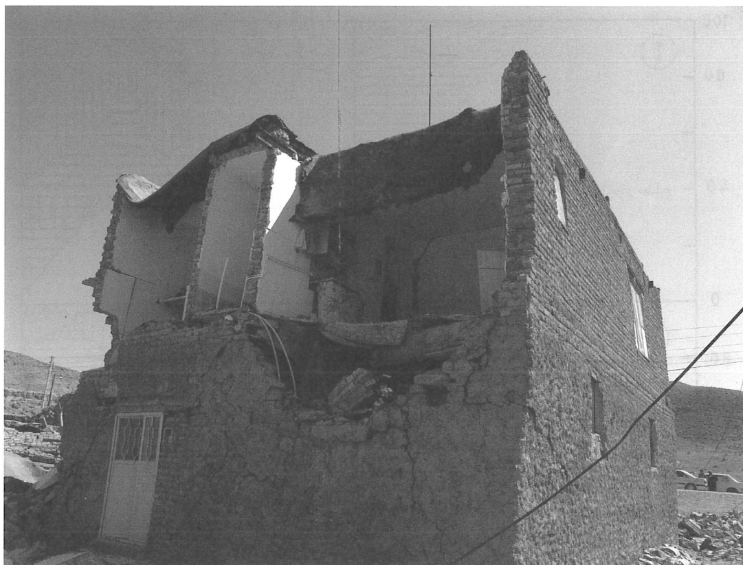
شکل ۵- خانه روستایی با دیوارهایی متشکل از مصالح گوناگون
