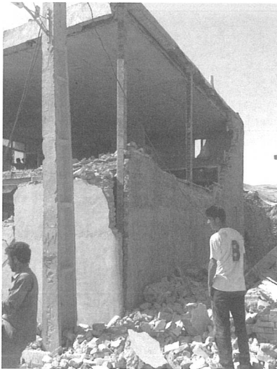
شکل ۱۲- مقطع ضعیف و مستعد کمانش ستون های فولادی
