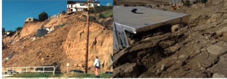
شکل (۳-۷): زمین‌لغزش و تخریب سازه‌های بالا و پایین‌دست شیروانی
