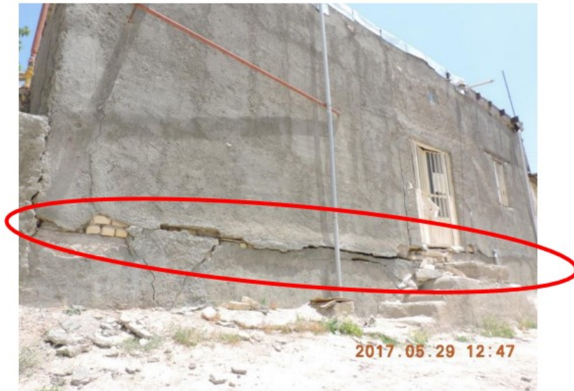
شکل (۵-۶): نمونه‌ای از شکست به وجود آمده در پی به صورت جداسدگی دیوارها از کرسی چینی
