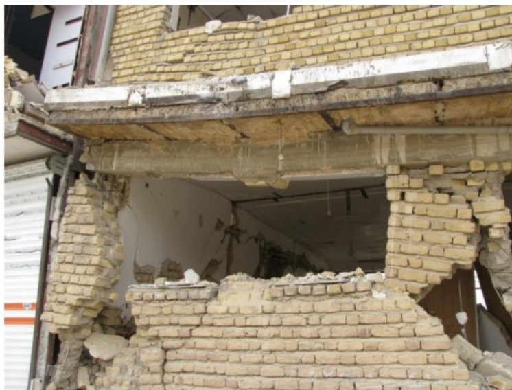
شکل (۶-۲۱): جابجایی مشهود ماندگار طبقات یک ساختمان مصالح بنایی کلاف دار
