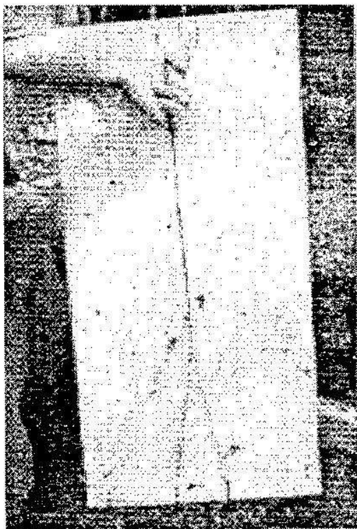
شکل ۱۳ - نحوه قرار گرفتن مهار سیمی در پشت سنگ
