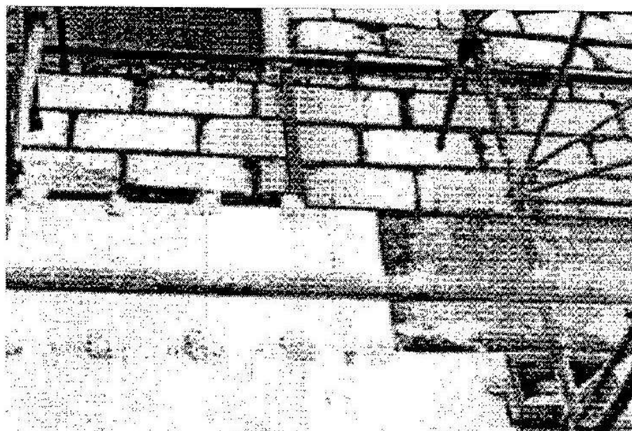
شکل ۱۷ - طرز قرار گرفتن قلابها روی سطوح آجرکاری
