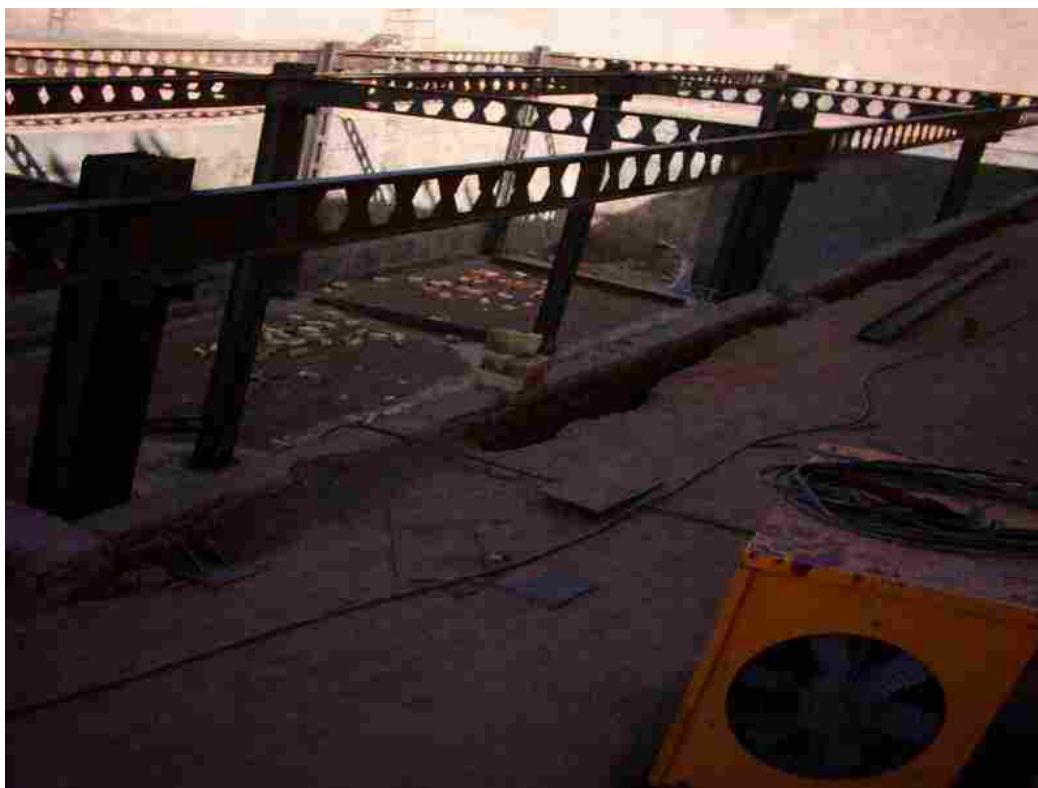
عملیات مونتاژ اسکلت سازه موتورخانه مرکزی
