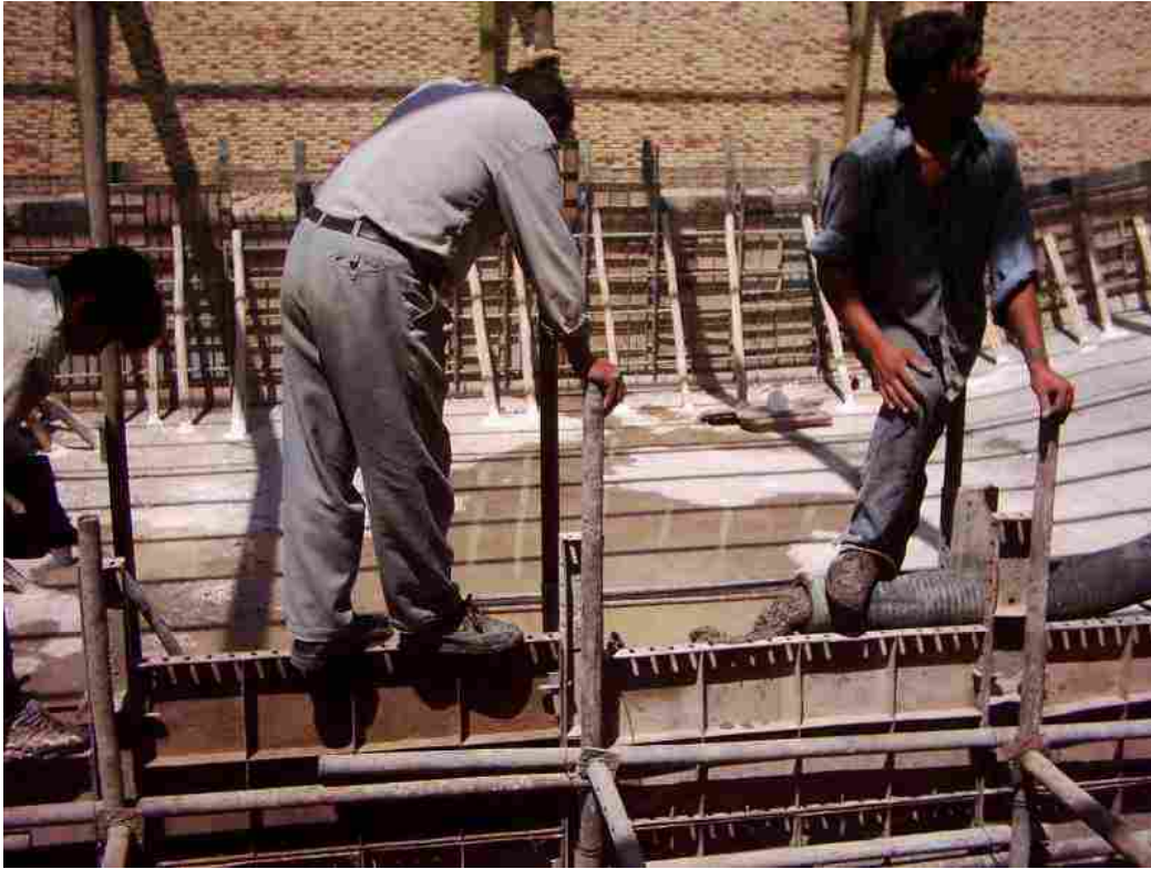
شروع عملیات بتن ریزی بدنه کاسه
