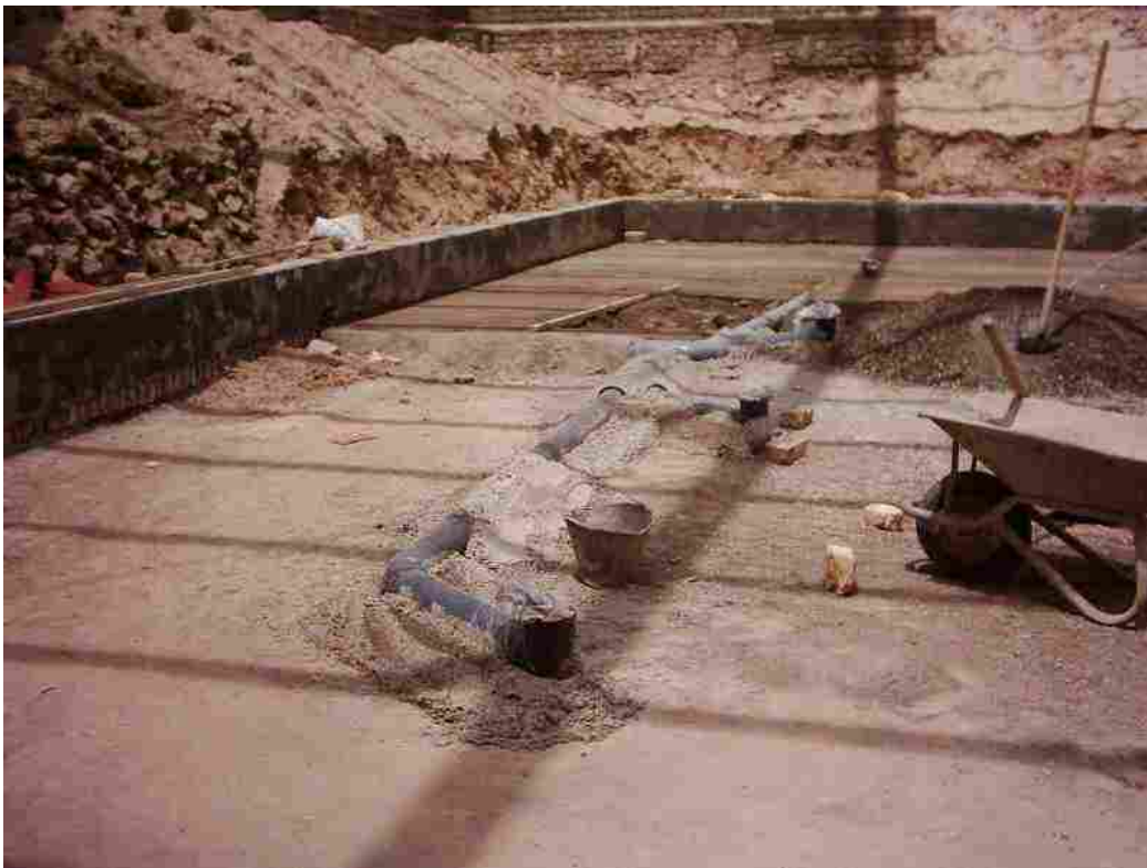
کار گذاشتن لوله های کف استخر که در زیر کاسه مدفون می شوند
