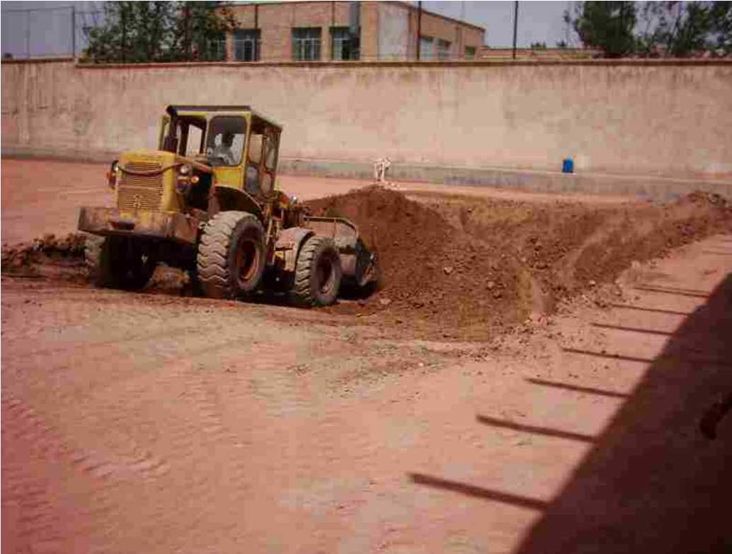
گودبرداری موتورخانه مرکزی واقع در کنار زمین تنیس
