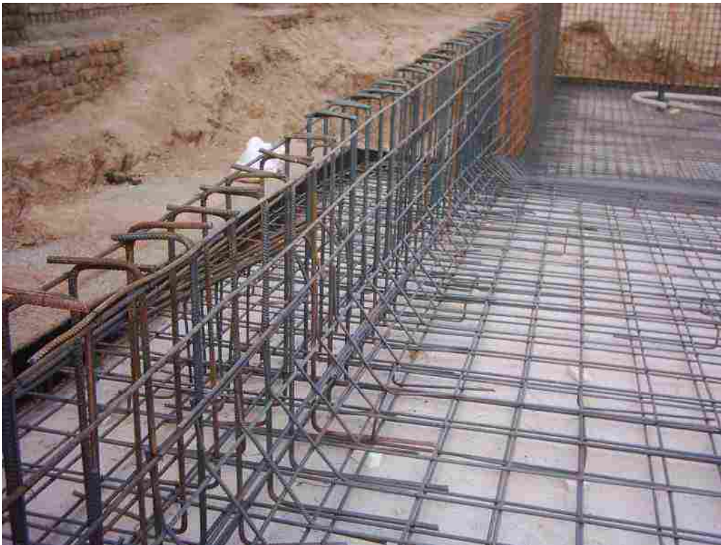
آرماتور بندی کف و دیواره در نمایی دیگر
