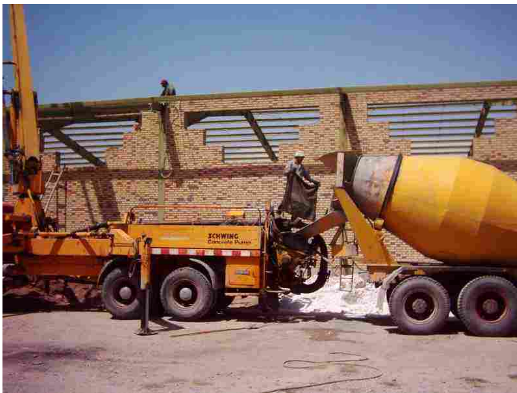
استقرار پمپ هوایی در بیرون از سوله ( ضلع غربی سوله )
