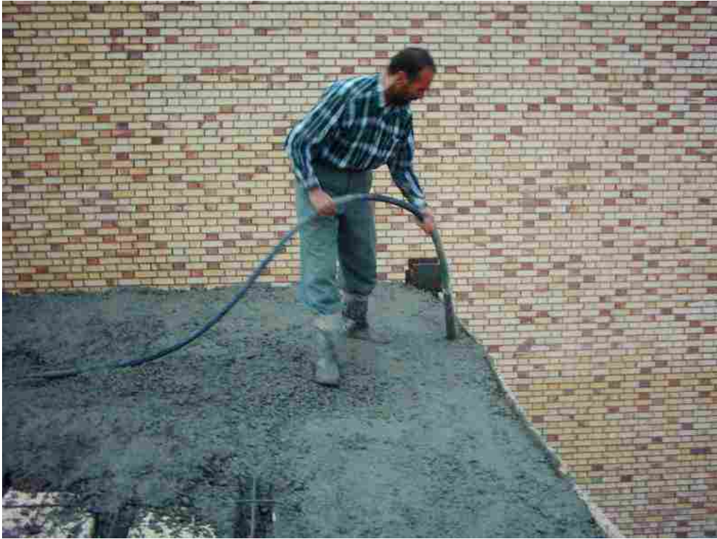
بتن ریزی سقف
