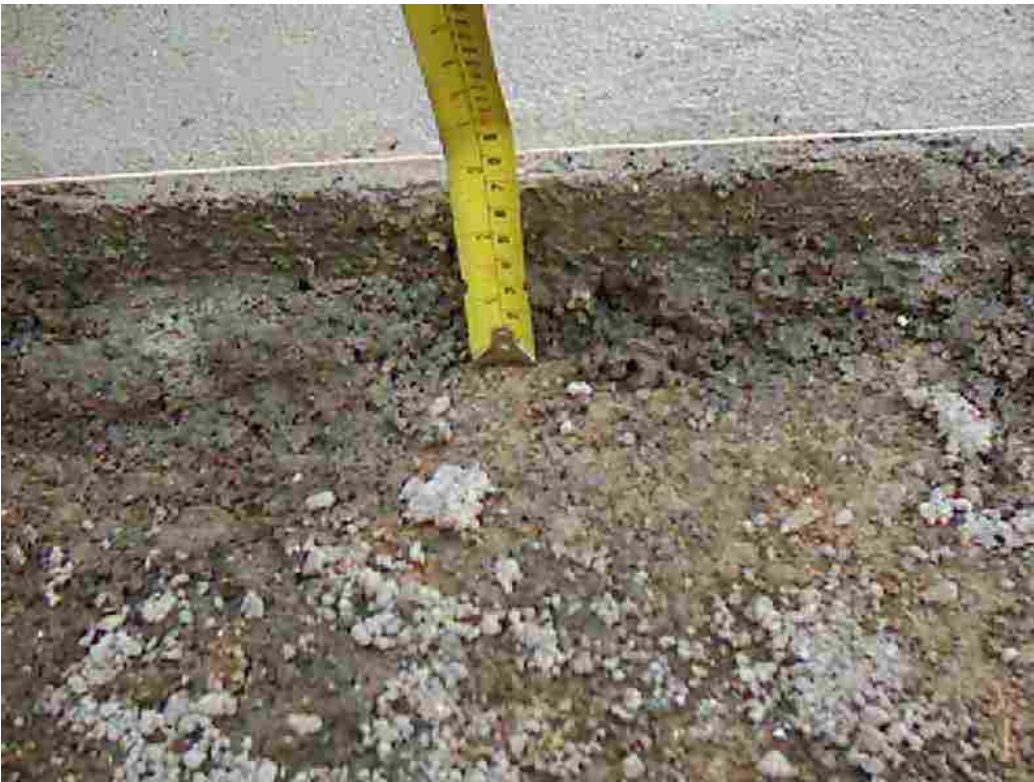
میزان ضخامت بتن مگر نشان داده شده است
