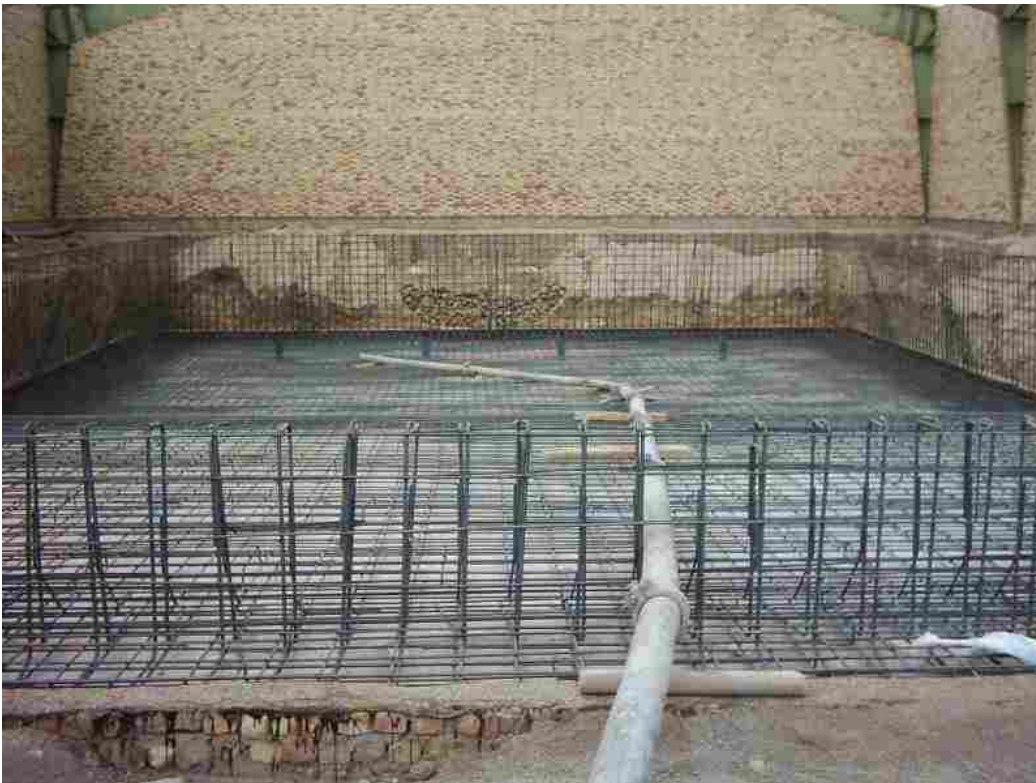
جایگذاری لوله پمپ زمینی بتن در جای مناسب
