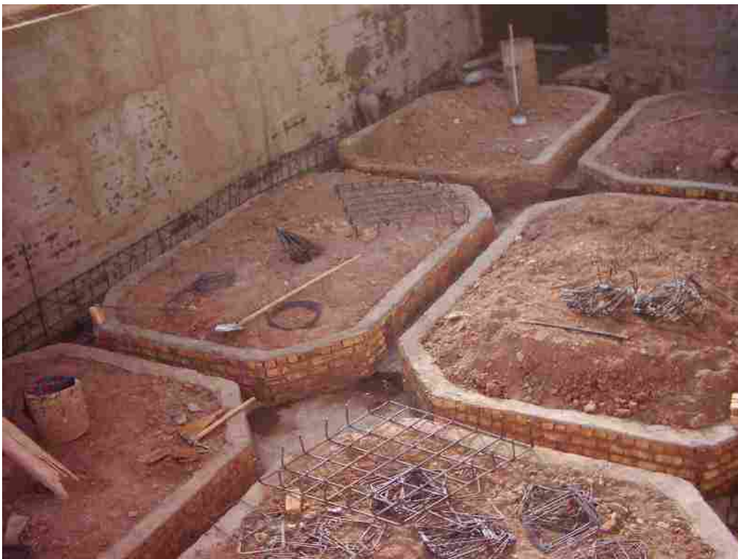
قالب بندی پی ها به صورت آجری و شروع عملیات آرماتور گذاری
