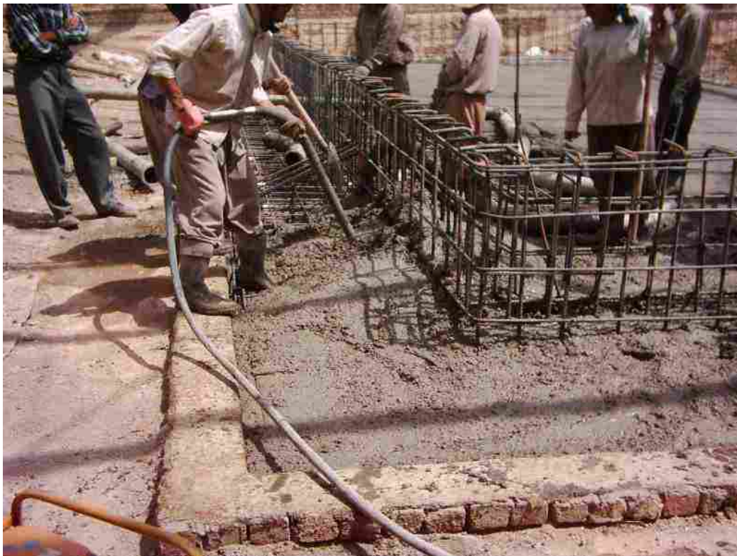
بتن ریزی کف کاسه
