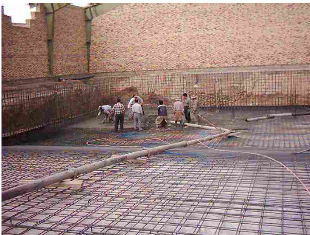
بتن ریزی از آخرین نقطه کاسه
