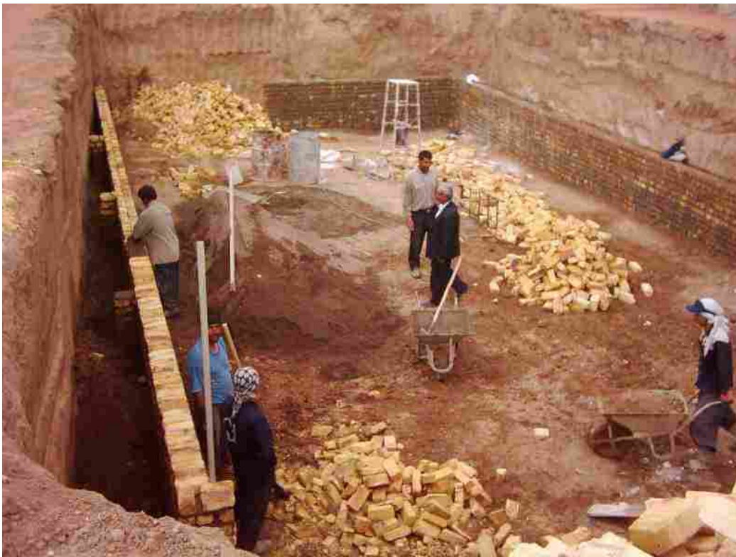
دیوار چینی اطراف گود برداری
