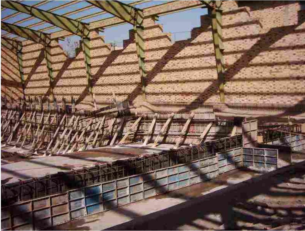
اجرای قالب بندی بندنه کاسه
