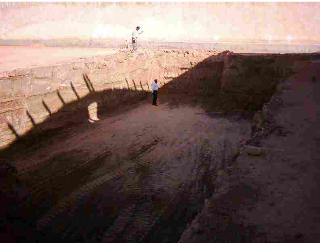
پایان گودبرداری ساختمان موتورخانه مرکزی
