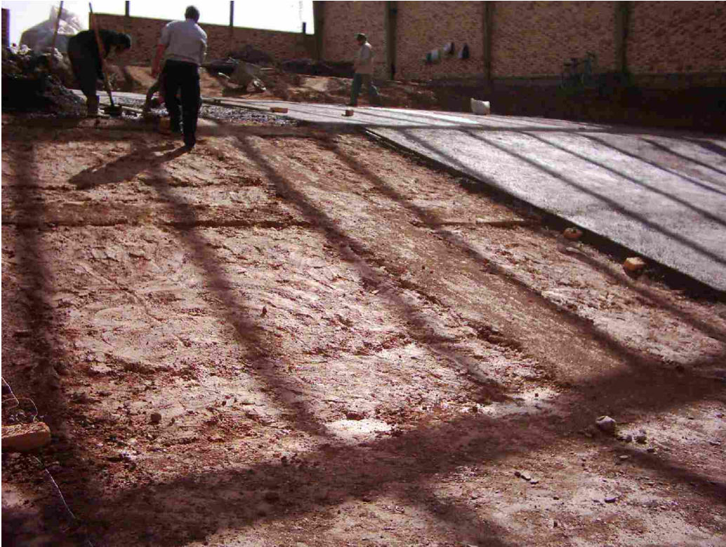
مرحله رگلاژ و ریختن بتن مگر در زیر سطح کاسه
