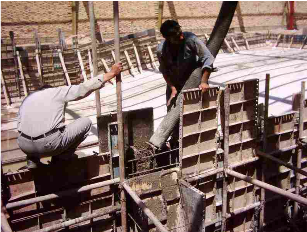
بتن ریزی بدنه کاسه از نمای دیگر
