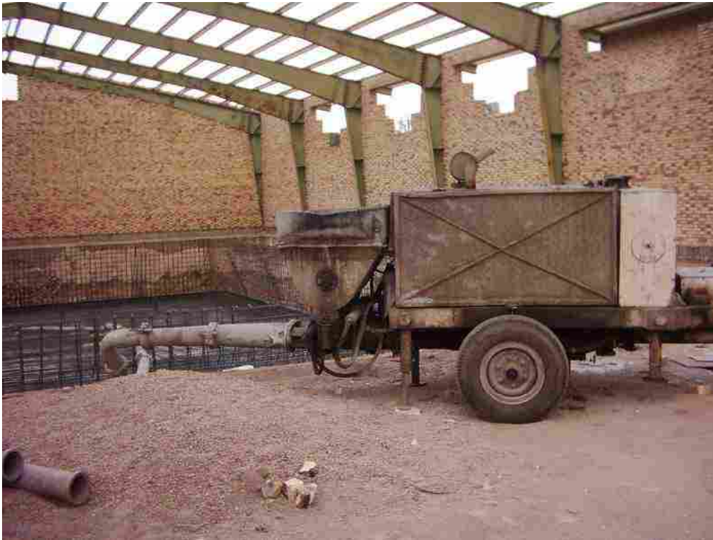
بتن ریزی کف کاسه توسط پمپ زمینی
