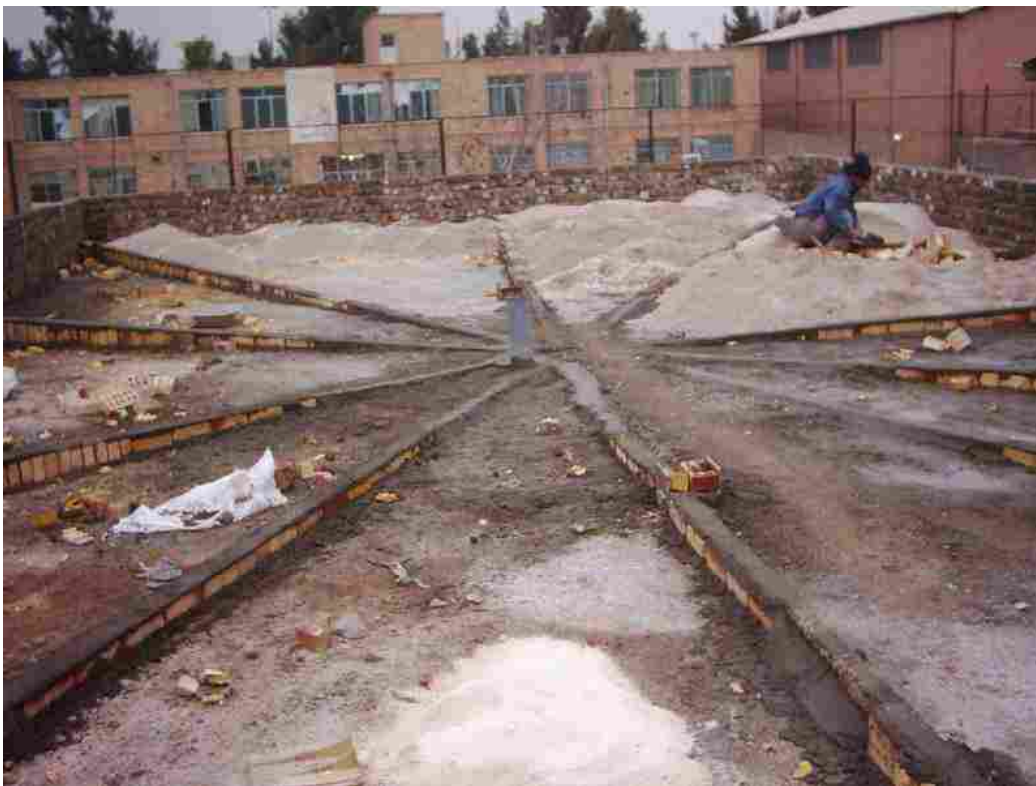
کرم بندی سقف موتورخانه مرکزی
