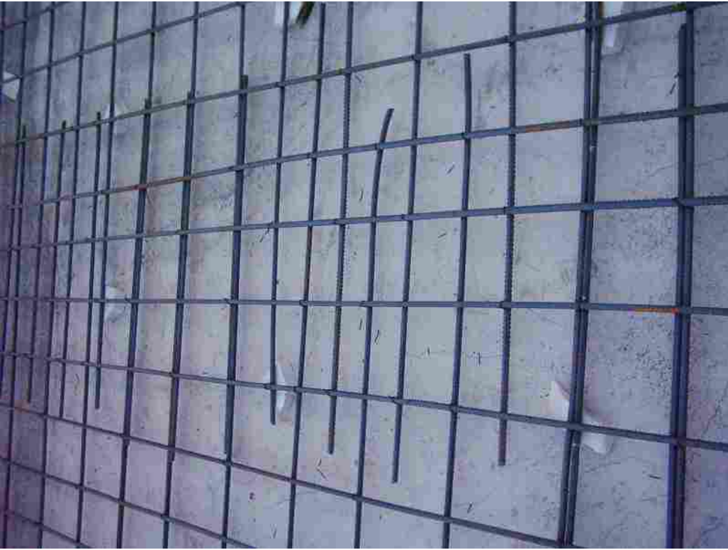
مش بندی کف از نمایی نزدیک تر
