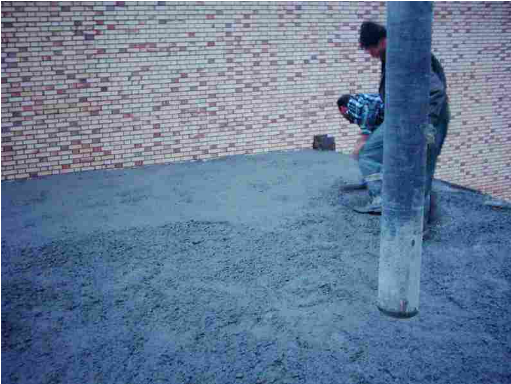
صاف کردن سطح بتن سقف
