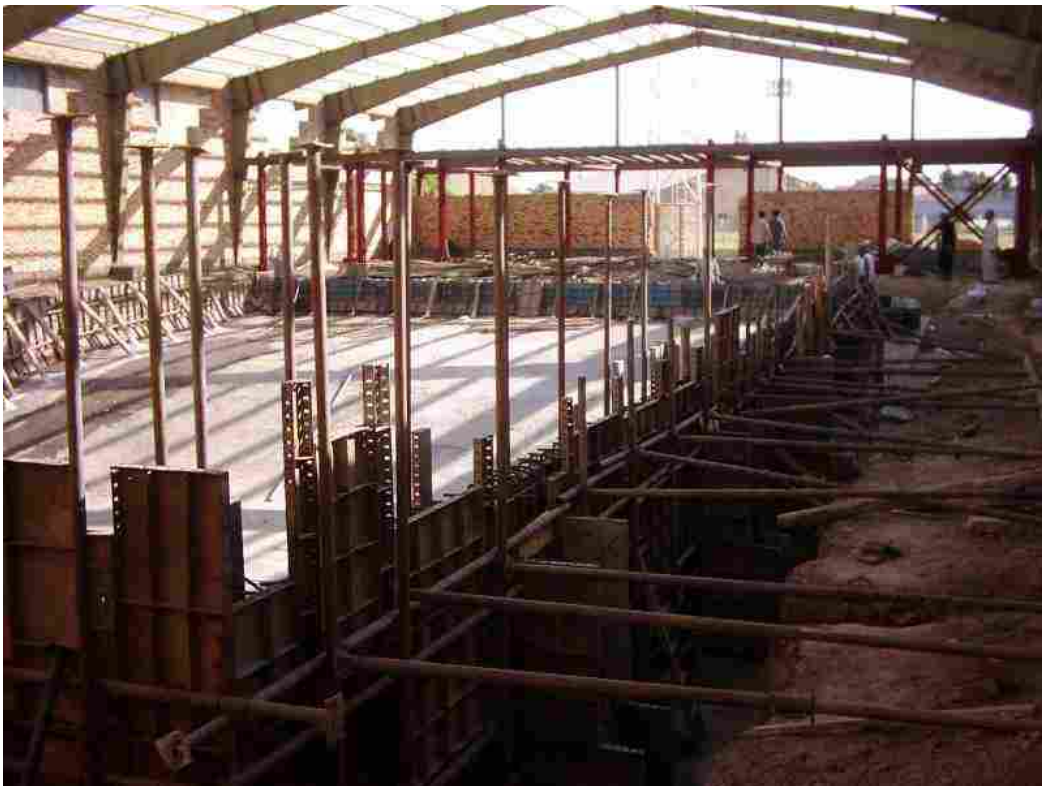
قالب بندی دیواره کاسه از نمای دیگر
