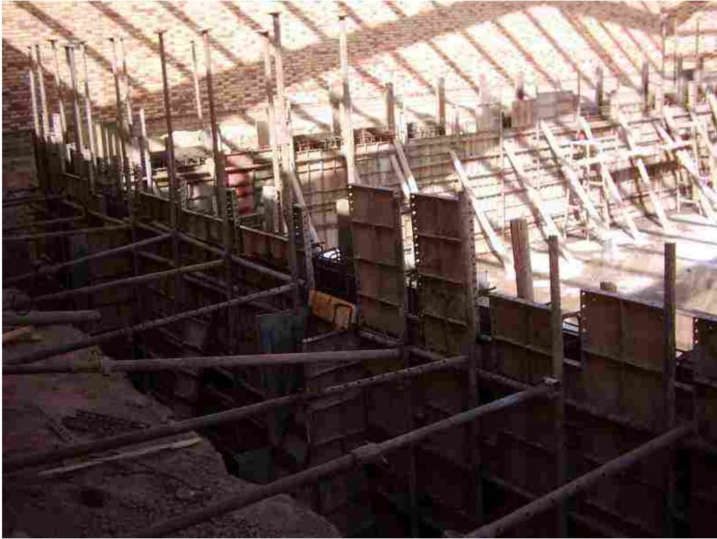
چگونگی قرار گیری پشت بند ها
