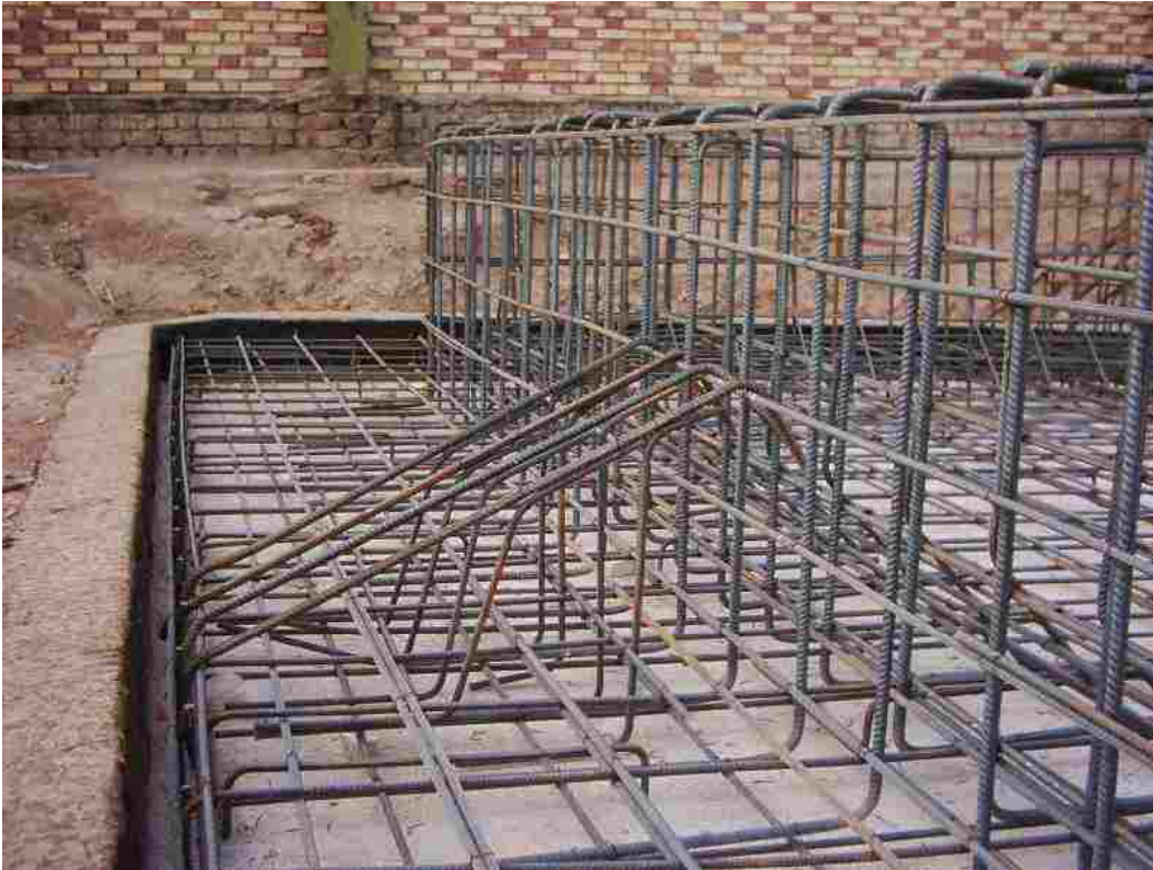
الحاق آرماتور های بدنه کاسه به آرماتور های کف و نیز جزئیات پشت بند کاسه
