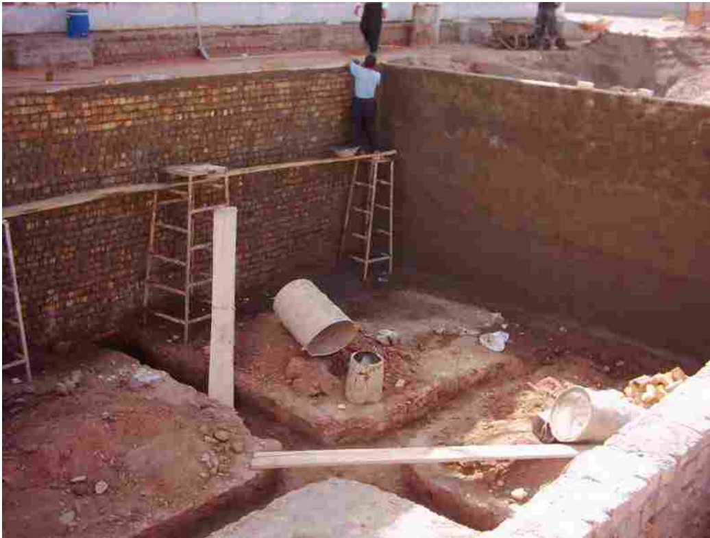
کشیدن پلاستر سیمانی روی دیوار سیمانی و نیز حفاری محل پی ها
