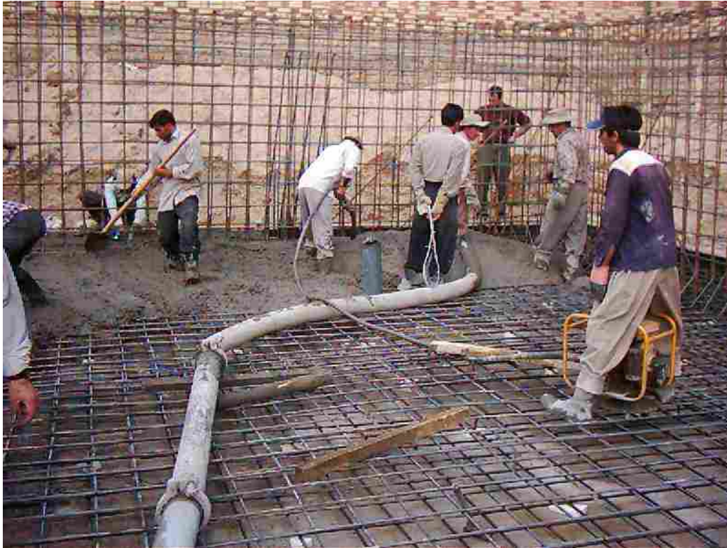
مراحل بتن ریزی کف از منظری دیگر ( استفاده از ویراتور در شکل دیده می شود )
