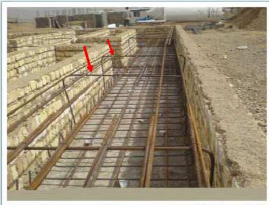
بستن خرک به صورت مورب در فنداسیون
