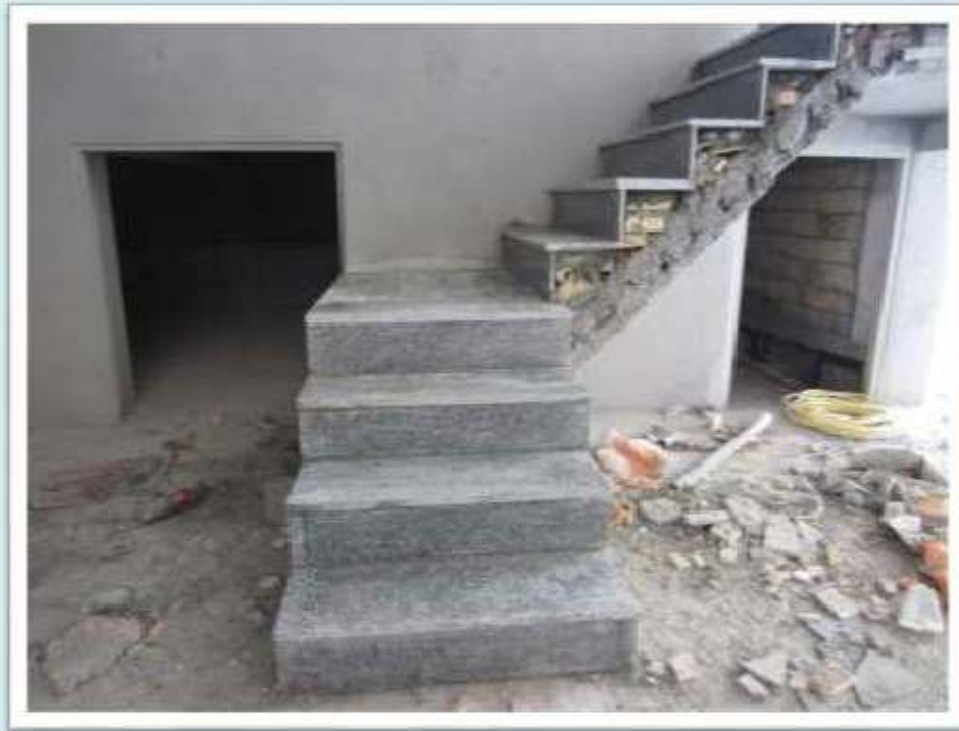
۳۴- سنگ زنی پله داخلی ساختمان
