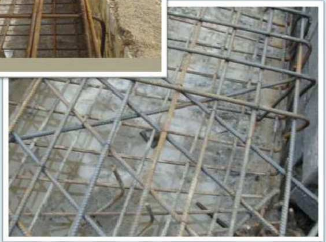
بستن خرک به صورت مورب در فنداسیون
