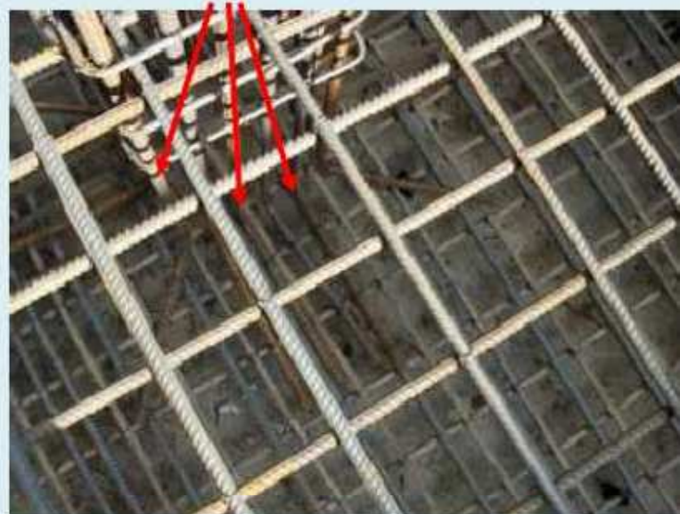
۱۰- خم ستون : ۱۶ برابر قطر میلگرد \phi 16
