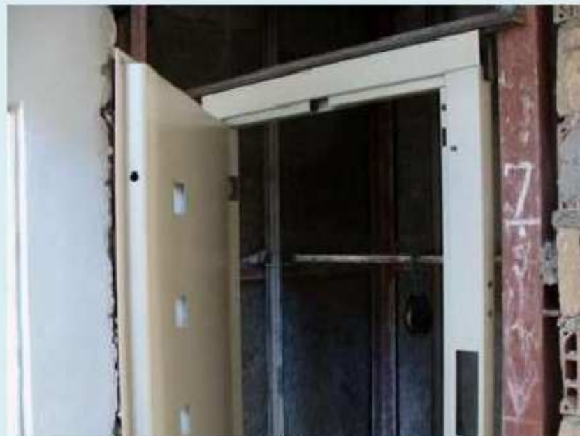
نصب درب آسانسور
