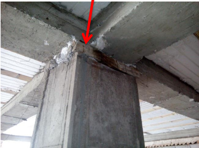
شکل ۱۱. اجرای نامناسب بتن ریزی و قالب بندی سقف
