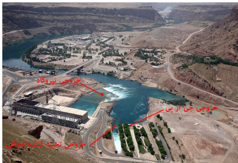
شکل ۴-۶- نمای پایین دست خروجی های مختلف سد [مهتاب قدس]
