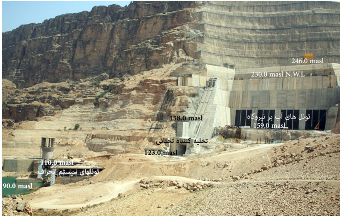
شکل ۳-۶- نمای بالادست خروجی های مختلف سد (داخل مخزن سد) [مهتاب قدس]
