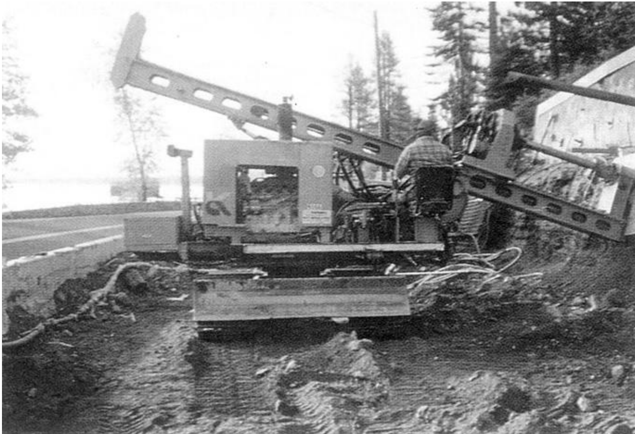
شکل ۸-۴: مته کاری برای میخ توسط روش چرخشی.
