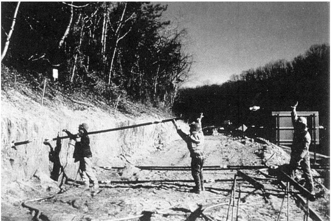
شکل ۴-۶: برداشت ابتدائی گود و نصب میخ.
