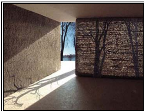
شکل ۳: نمایی از دیوار ساخته شده با بلوک های نیمه سازه ای سو گذران ( نیمه شفاف )
