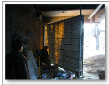
شکل ۳: نمایی از دیوار ساخته شده با بلوک های نیمه سازه ای سو گذران ( نیمه شفاف )
