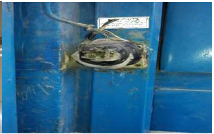
شکل ۵-۷ و ۵-۸ وضعیت پرسیک برق رسانی کارگاه
