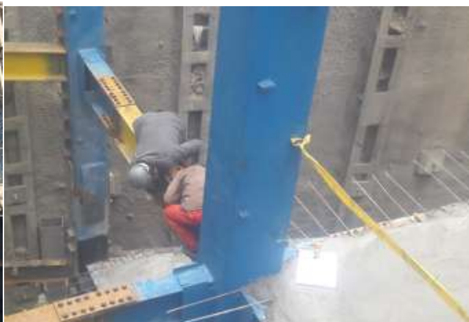
اشکال ۴-۱۱ و ۴-۱۲- عدم استفاده از تجهیزات حفاظت فردی و کاربرد ارتفاع مناسب و کار بر روی جایگاه نایمن
