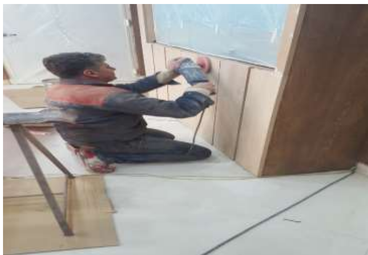
اشکال ۷-۴- و ۸-۴- عدم استفاده از تجهیزات حفاظت فردی و محافظ چشم و صورت در کار با دستگاه فرز
