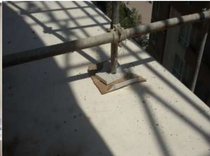
شکل ۱۱-۳ و ۱۲-۳ مربوط به وضعیت نایمن کار در ارتفاع و استفاده از چوب بست نایمن برخلاف ضوابط
