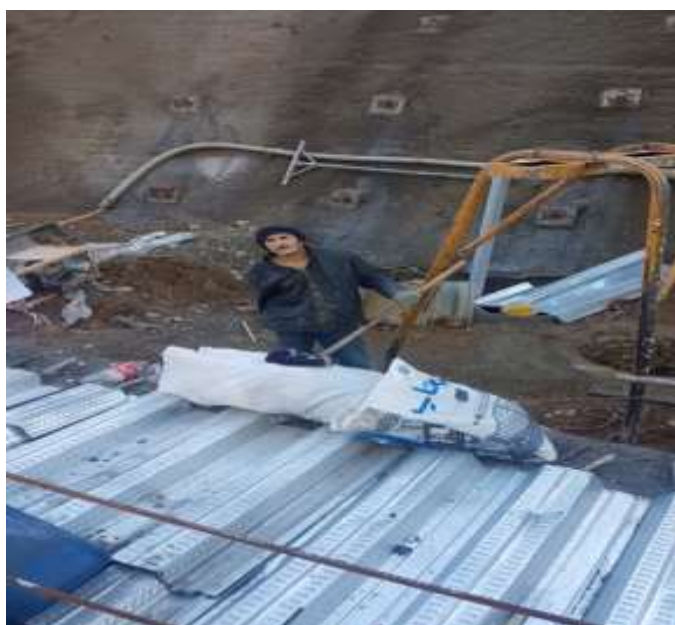
شکل ۷-۵ و شکل ۷-۶ - عدم وجود وسایل مناسب حفاری برای کارگران و مقنی چاه از قبیل سه پایه طناب نجات همایل بند کامل بدن و..
