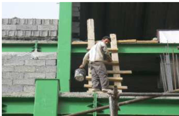
اشکال ۱۵-۴ و ۱۶-۴- عدم استفاده از تجهیزات حفاظت فردی مناسب و ریسک بالای خطرات کار در ارتفاع
