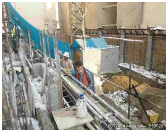
اشکال ۱۵-۴ و ۱۶-۴- عدم استفاده از تجهیزات حفاظت فردی و کار در ارتفاع مناسب و جایگاه کار ناایمن و پرریسک
