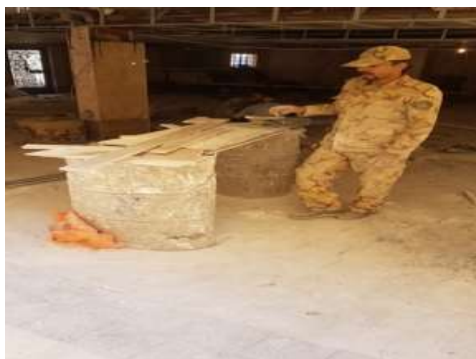
اشکال ۴-۱۱ و ۴-۱۲- عدم استفاده از تجهیزات حفاظت فردی و کاربرد ارتفاع مناسب و کار بر روی جایگاه نایمن
