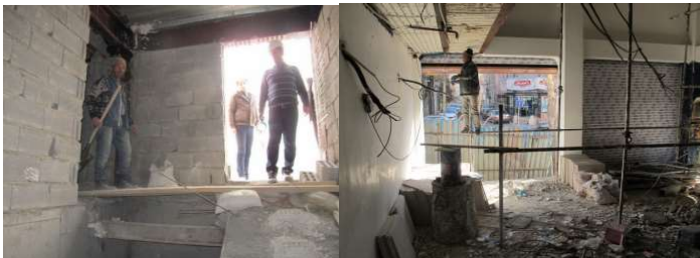
اشکال ۱۵-۳ و ۱۶-۳- وضعیت پرریسک کار در ارتفاع و چوب بستهای ترک خورده ولق برخلاف ضوابط
