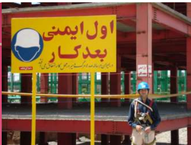
اشکال ۲-۲۱ و ۲-۲۲ استفاده مناسب از وسایل حفاظت فردی و تجهیزات کار در ارتفاع
