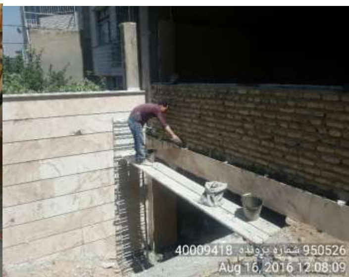
اشکال ۱۵-۴ و ۱۶-۴- عدم استفاده از تجهیزات حفاظت فردی و کار در ارتفاع مناسب و جایگاه کار ناایمن و پرریسک
