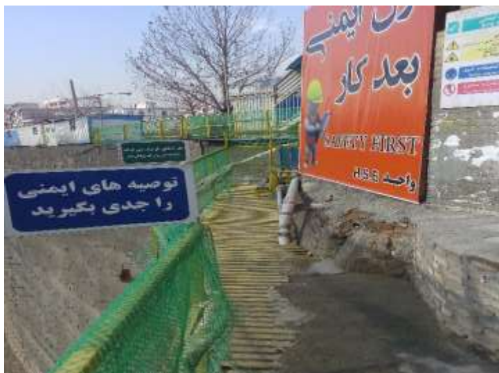
اشکال ۲-۱۷ و ۲-۱۸ وضعیت ایمن راه ها و پله های دسترسی به گود و اجرای نرده حفاظتی و علائم و تابلوهای هشداردهنده
