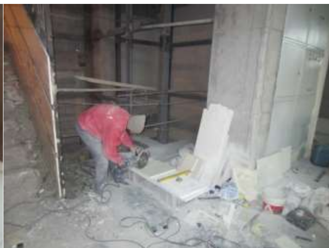
اشکال ۷-۴- و ۸-۴- عدم استفاده از تجهیزات حفاظت فردی و محافظ چشم و صورت در کار با دستگاه فرز
