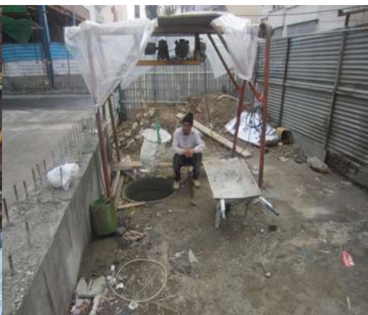
شکل ۷-۵ و شکل ۷-۶ - عدم وجود وسایل مناسب حفاری برای کارگران و مقنی چاه از قبیل سه پایه طناب نجات همایل بند کامل بدن و..
