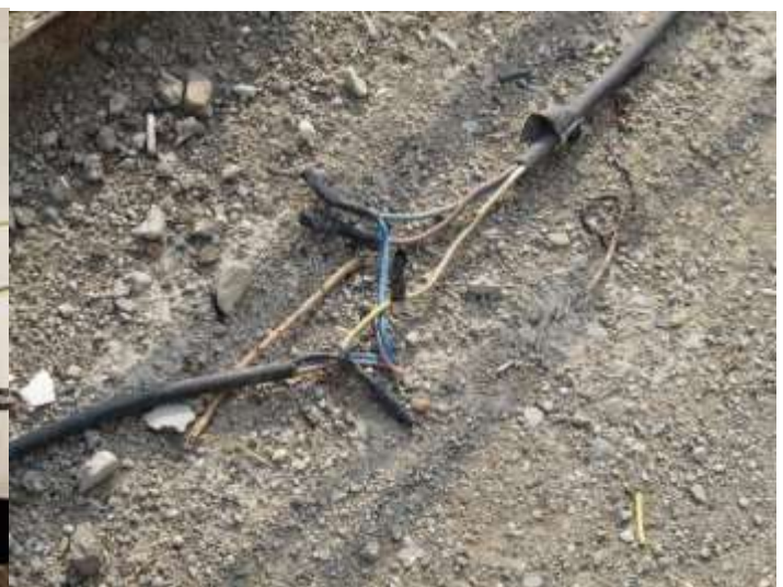
شکل ۵-۱۱ و ۵-۱۲ وضعیت پرسیک برق رسانی کارگاه
