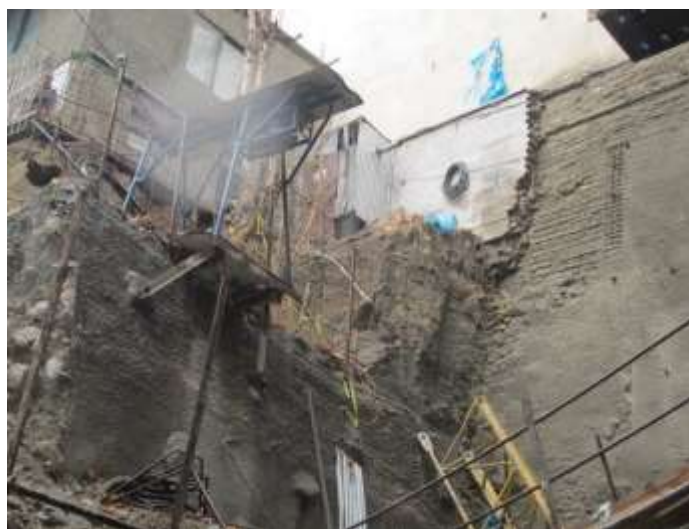
شکل ۵-۶ و ۶-۶- نحوه نامناسب استقرار پایه های بالابر وعدم اتصال و فیکس نمودن آنها
