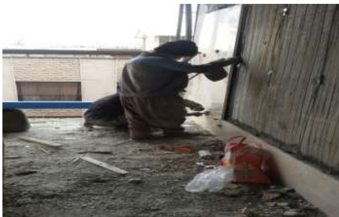
اشکال ۳-۴- و ۴-۴- عدم استفاده از تجهیزات حفاظت فردی و کاربرروی جایگاه نالیمن و پرریسک
