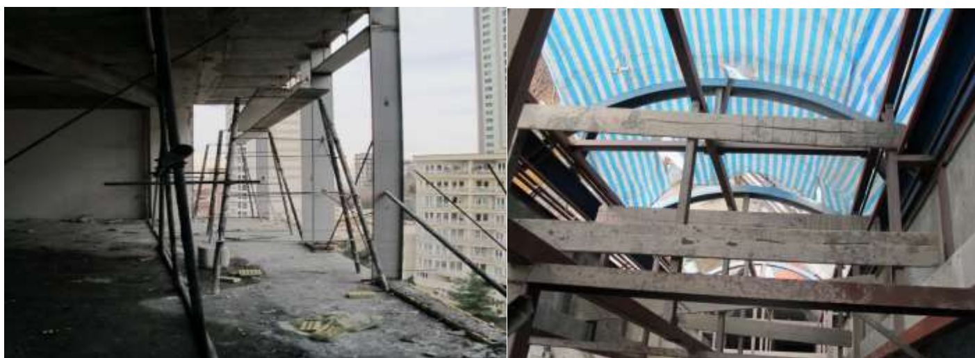
اشکال ۱۷-۳ و ۱۸-۳- عدم بستن تخته های زیرپایی واستفاده از تخته های زیرپایی ترک خورده ونالین
