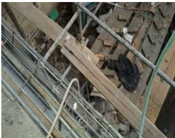
اشکال ۱۳-۳ و ۱۴-۳ وضعیت پرریسک کار در ارتفاع و چوب بستهای ترک خورده و لق و عدم بستن تخته های زیرپایی و عدم اجرای پاخور و حفاظ
