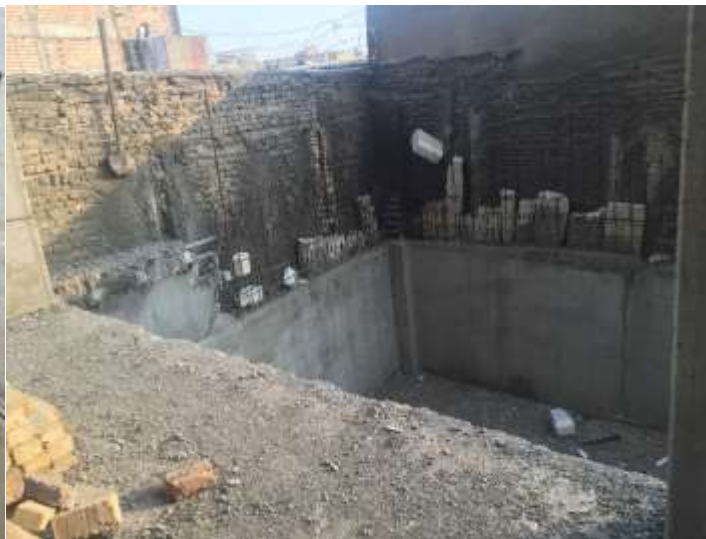
شکل ۲-۷ عدم اجرای نرده حفاظتی و پاخورپرتگاه های طبقات
