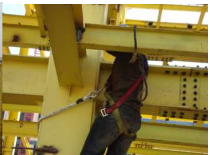
اشکال ۲-۹ و ۲-۱۰ - استفاده مناسب از وسایل و تجهیزات کار در ارتفاع و هارنس و لایف لاین (طناب نجات) و همایل بند
