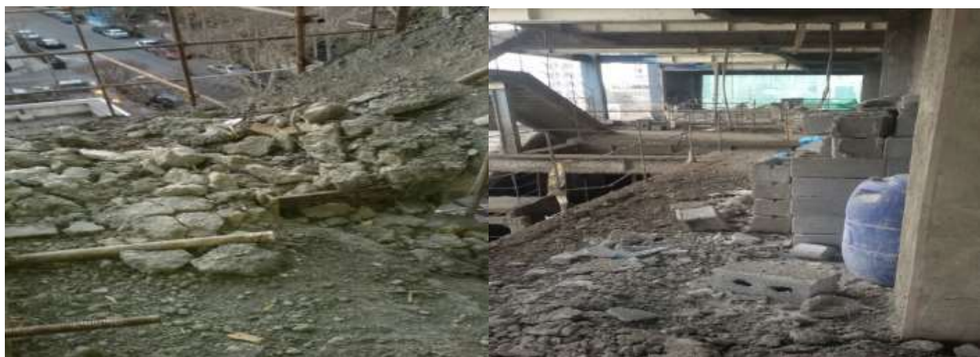
اشکال ۹-۱۲ و ۱۰-۱۲ مربوط به بی نظمی کارگاه و وضعیت نامناسب دیو نخاله ها و مصالح و وضعیت نایمن ۵S
