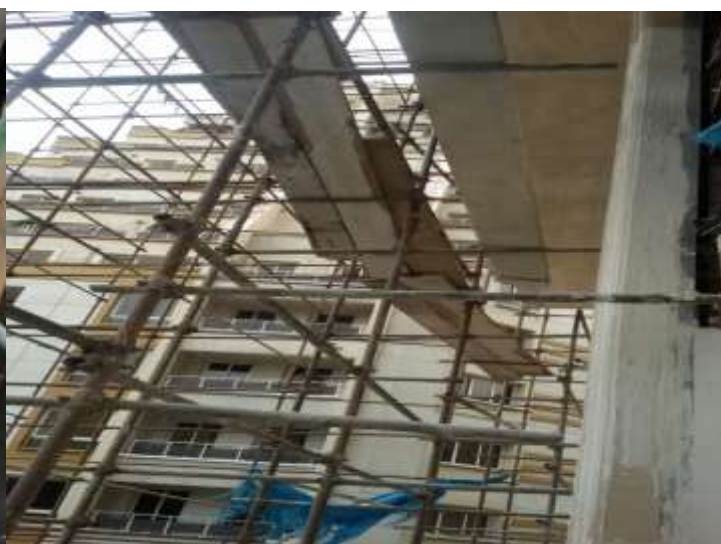
اشکال ۱۳-۳ و ۱۴-۳ وضعیت پرریسک کار در ارتفاع و چوب بستهای ترک خورده و لق و عدم بستن تخته های زیرپایی و عدم اجرای پاخور و حفاظ
