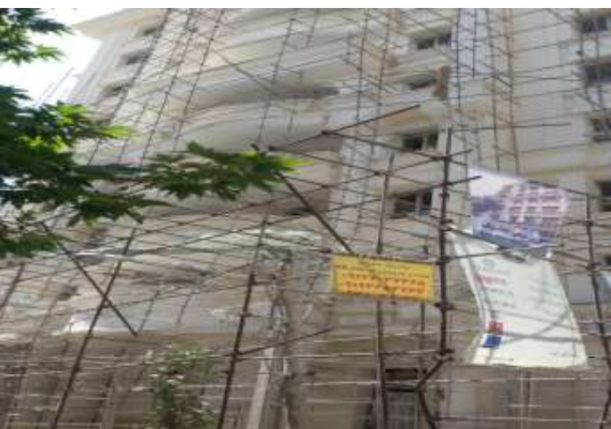
اشکال ۱۵-۳ و ۱۶-۳ وضعیت پرخطر داربست ها و زنگ زدگی، لق و عدم ایستایی و عدم رعایت فواصله پایه ها و چوب بست نایمن
