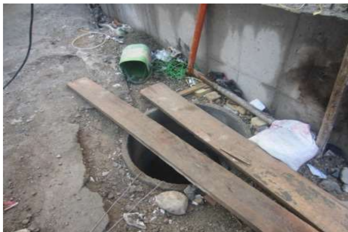
شکل ۷-۳ و شکل ۷-۴ - عدم وجود درپوش حفاظتی ورها کردن چاه و خطرات افتادن و سقوط در چاه
