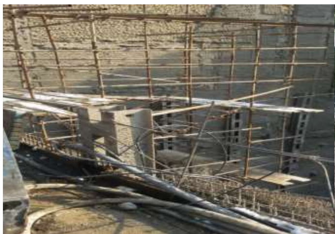
اشکال ۱۵-۳ و ۱۶-۳ وضعیت پرخطر داربست ها و زنگ زدگی، لق و عدم ایستایی و عدم رعایت فواصله پایه ها و چوب بست نایمن
