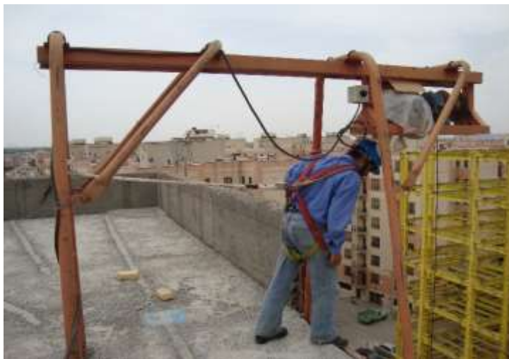
اشکال ۲-۹ و ۲-۱۰ - استفاده مناسب از وسایل و تجهیزات کار در ارتفاع و هارنس و لایف لاین (طناب نجات) و همایل بند
