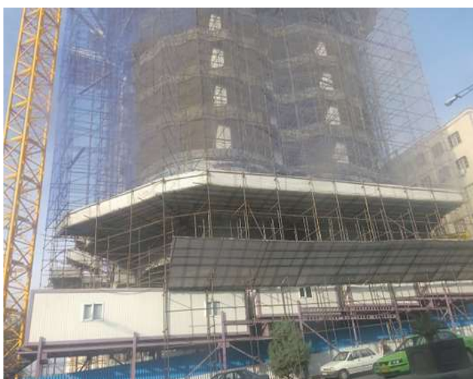
اشکال ۲-۱۹ و ۲-۲۰ نحوه مناسب و ایمن اجرای پوشش و حفاظ مناسب نمای ساختمان و اجرای سپر محافظتی ساختمان
