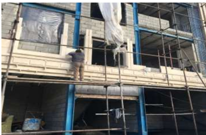
اشکال ۴-۱۱ و ۴-۱۲- عدم استفاده از تجهیزات حفاظت فردی و کاربرد ارتفاع مناسب و کار بر روی جایگاه نایمن
