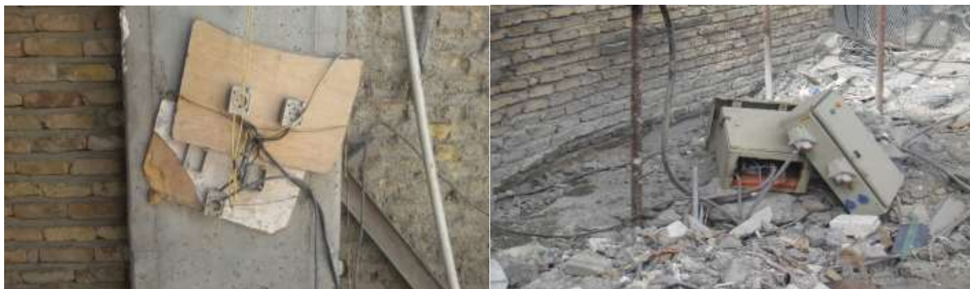
شکل ۱۳-۵ و ۱۴-۵ وضعیت پریسک برق رسانی کارگاه
