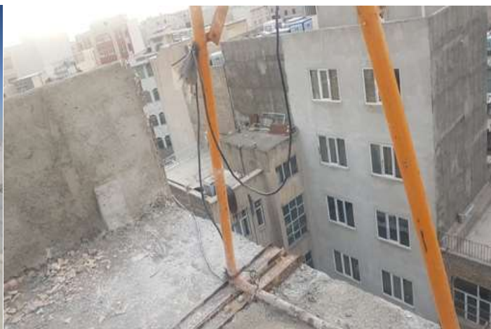
شکل ۳-۶ و ۴-۶-عدم اتصال مناسب پایه های بالابر و خطرات واژگونی ناشی از چرخش وافتادن
