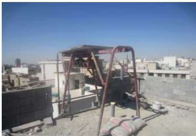
شکل ۳-۶ و ۴-۶-عدم اتصال مناسب پایه های بالابر و خطرات واژگونی ناشی از چرخش وافتادن
