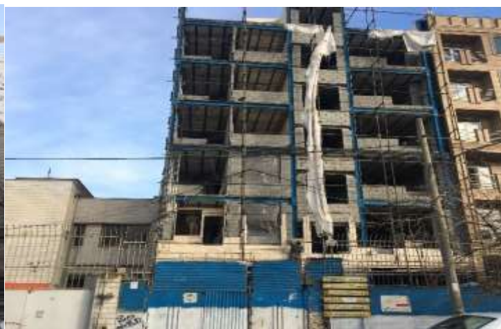
اشکال ۳-۱۳-۴- عدم اجرای پوشش مناسب و ایمن نما و سرپوش و سپر محافظتی ایمن
