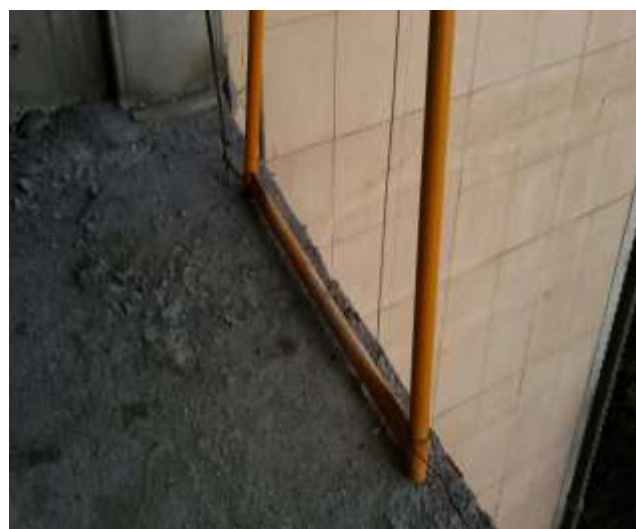
شکل ۵-۶ و ۶-۶- نحوه نامناسب استقرار پایه های بالابر وعدم اتصال و فیکس نمودن آنها
