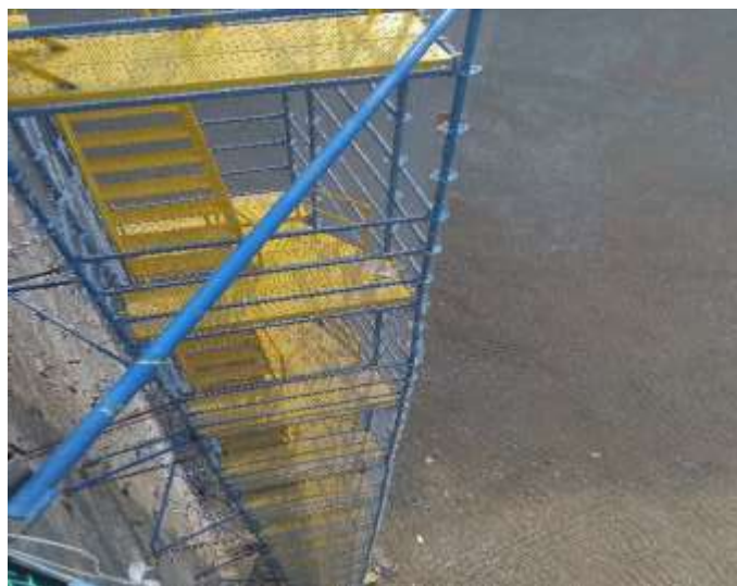
اشکال ۲-۱۷ و ۲-۱۸ وضعیت ایمن راه ها و پله های دسترسی به گود و اجرای نرده حفاظتی و علائم و تابلوهای هشداردهنده
