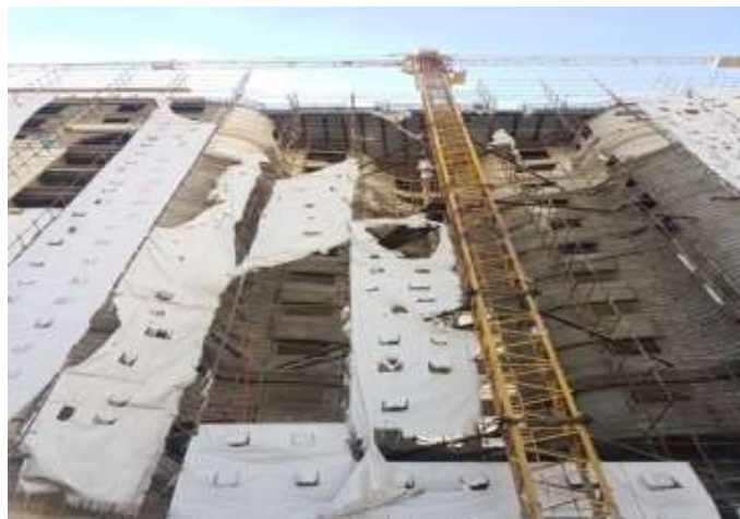
اشکال ۳-۱۳-۴- عدم اجرای پوشش مناسب و ایمن نما و سرپوش و سپر محافظتی ایمن
