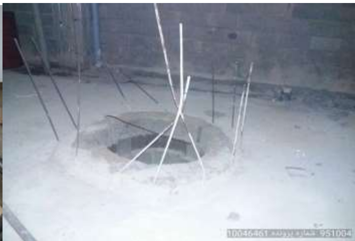
اشکال ۷-۷ و ۷-۸ - عدم نصب سرپوش حفاظتی مناسب بر روی دهانه چاه و وضعیت پرریسک آنها
