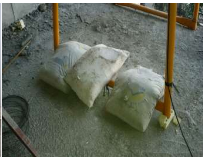
شکل ۷-۶ و ۸-۶- نحوه نامناسب استقرار پایه های بالابر وعدم اتصال و فیکس نمودن آنها
