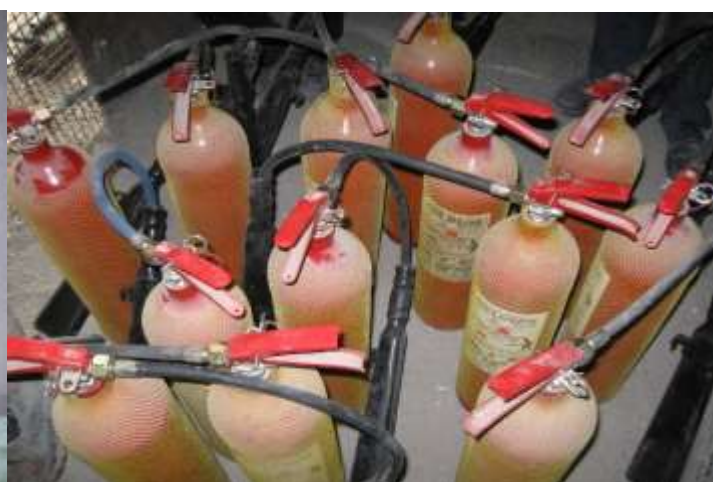
اشکال ۱۵-۲ و ۱۶-۲- استفاده از وسایل اطفای حریق در کارگاه
