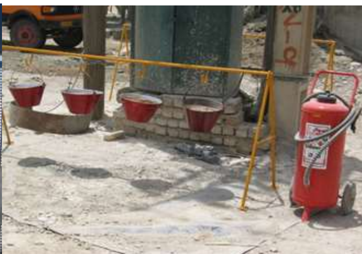
اشکال ۱۳-۲ و ۱۴-۲- استفاده از وسایل اطفای حریق در کارگاه
