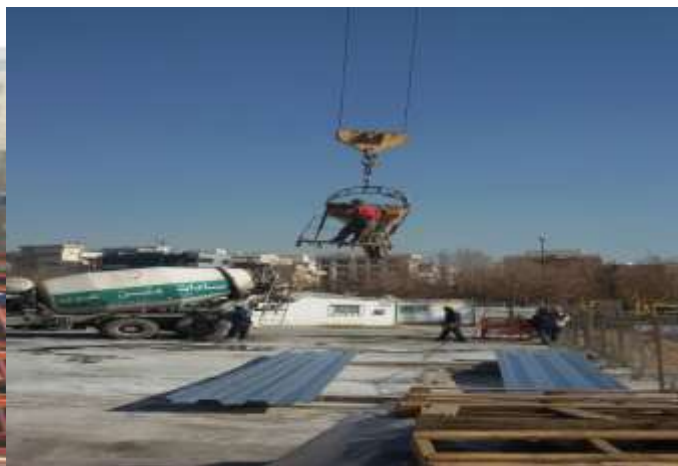
اشکال ۱-۱۰ و ۲-۱۰ وضعیت پرریسک و ناایمن حمل خطرناک کارگران با تاورکین
