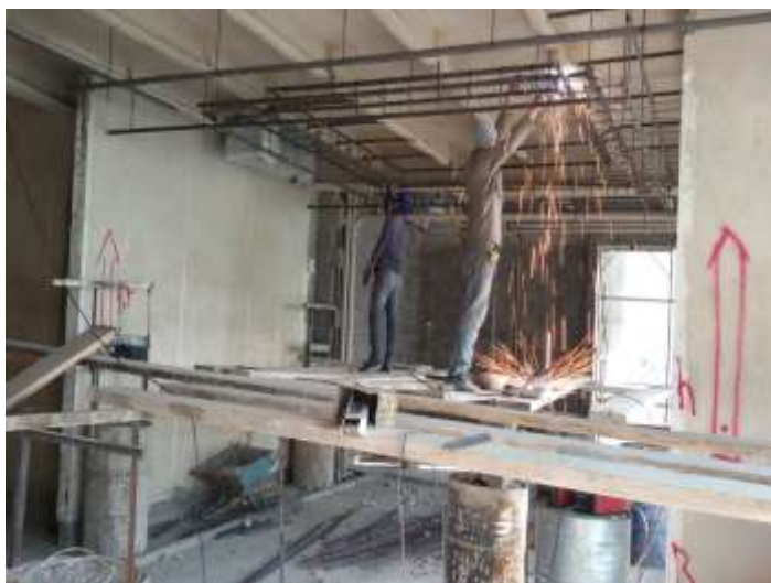
شکل ۱۱-۳ و ۱۲-۳ مربوط به وضعیت نایمن کار در ارتفاع و استفاده از چوب بست نایمن برخلاف ضوابط
