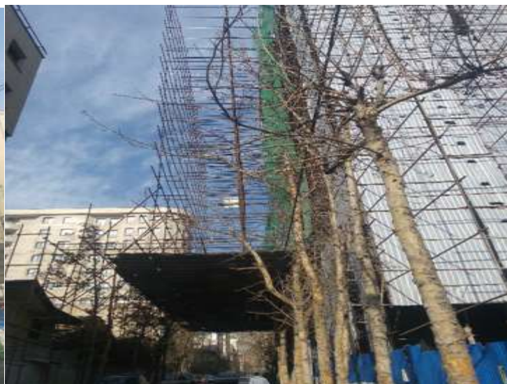
اشکال ۲-۱۹ و ۲-۲۰ نحوه مناسب و ایمن اجرای پوشش و حفاظ مناسب نمای ساختمان و اجرای سپر محافظتی ساختمان
