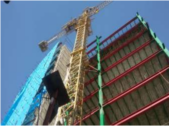
شکل ۲-۲ عدم اجرای نرده حفاظتی و پاخور پرتگاه ها
