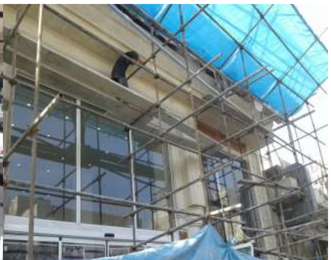
اشکال ۳-۹ و ۳-۱۰- وضعیت پرریسک کار در ارتفاع و چوب بسته های ترک خورده و لقی وعدم بستن تخته های زیرپایی وعدم اجرای پاخور و حفاظ داربست ها
