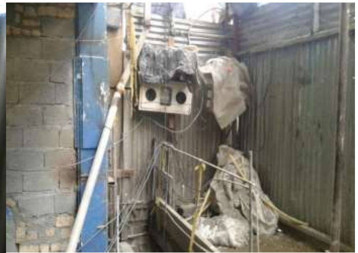
شکل ۵-۹ و ۵-۱۰ وضعیت پرسیک برق رسانی کارگاه
