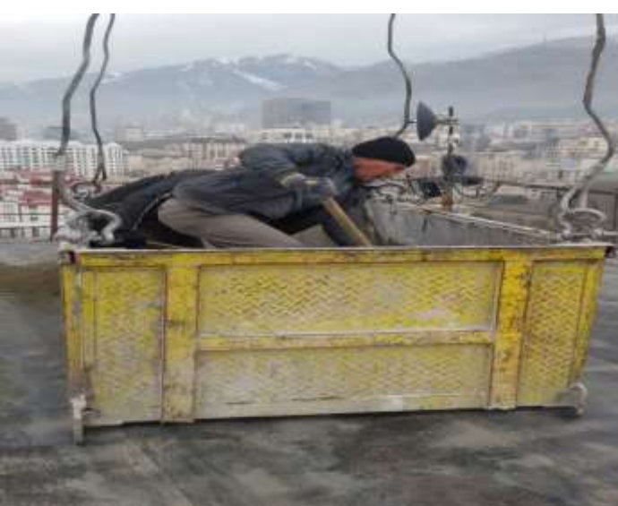
اشکال ۳-۱۰ و ۴-۱۰ وضعیت پرریسک و ناایمن حمل خطرناک کارگران با تاورکین
