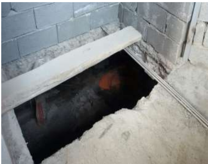
شکل ۲-۸ عدم اجرای نرده حفاظتی و پاخورپرتگاه های طبقات
