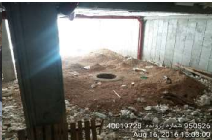
شکل ۷-۳ و شکل ۷-۴ - عدم وجود درپوش حفاظتی ورها کردن چاه و خطرات افتادن و سقوط در چاه
