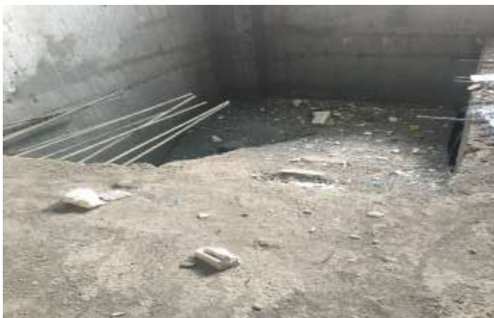
شکل ۲-۴ عدم اجرای نرده حفاظتی ایمن
