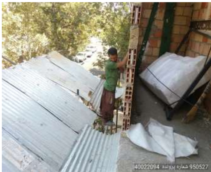
اشکال ۱۵-۴ و ۱۶-۴- عدم استفاده از تجهیزات حفاظت فردی و کار در ارتفاع مناسب و جایگاه کار ناایمن و پرریسک
