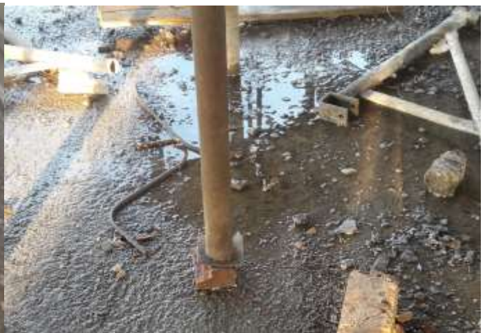
اشکال ۳-۵ و ۳-۶- نحوه اشتباه پرکردن زیر داربست ها و جک ها با استفاده از چوب و آجر وعدم تراز نمودن آنها با صفحه فلزی
