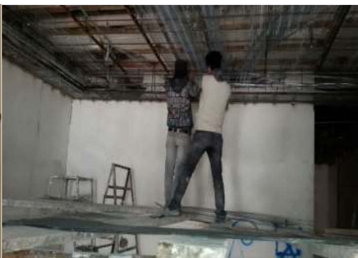
اشکال ۳-۴- و ۴-۴- عدم استفاده از تجهیزات حفاظت فردی و کاربرروی جایگاه نالیمن و پرریسک
