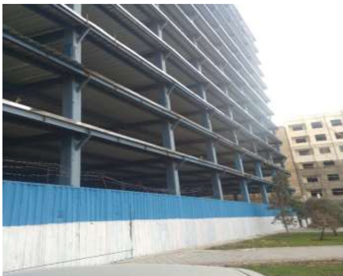
شکل ۲-۸ عدم اجرای نرده حفاظتی و پاخورپرتگاه های طبقات
