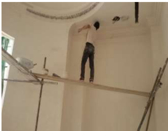
اشکال ۳-۴- و ۴-۴- عدم استفاده از تجهیزات حفاظت فردی و کاربرروی جایگاه نالیمن و پرریسک
