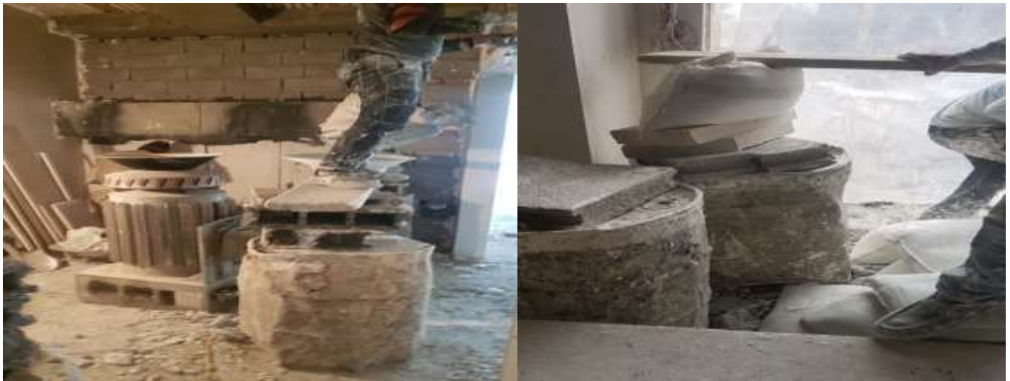
شکل ۱-۳-۲ و ۳-۳- مربوط به وضعیت نالایمن کاردرارتفاع واستفاده از چوب بست برخلاف ضوابط
