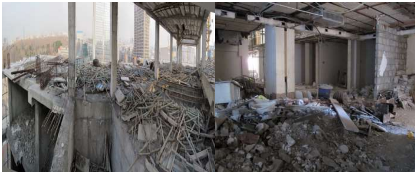
اشکال ۷-۱۲ و ۸-۱۲ مربوط به بی نظمی کارگاه و وضعیت نامناسب دیو نخاله ها و مصالح و وضعیت نایمن ۵S
