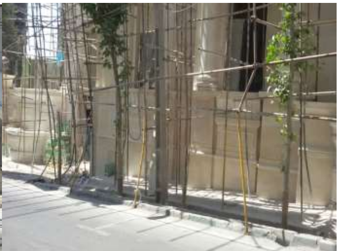
اشکال ۳-۷ و ۳-۸- وضعیت پرخطر داربست ها و زنگ زدگی لقی عدم ایستایی وعدم رعایت فواصله پایه ها و
