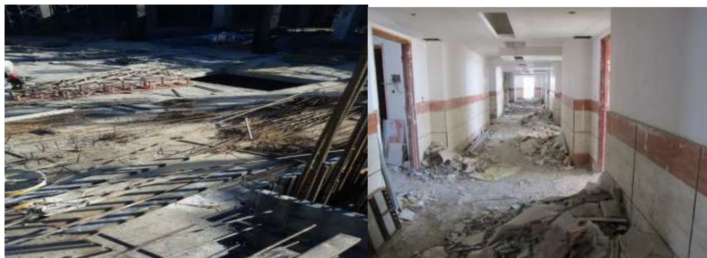
اشکال ۹-۱۲ و ۱۰-۱۲ مربوط به بی نظمی کارگاه و وضعیت نامناسب دیو نخاله ها و مصالح و وضعیت نایمن ۵S
