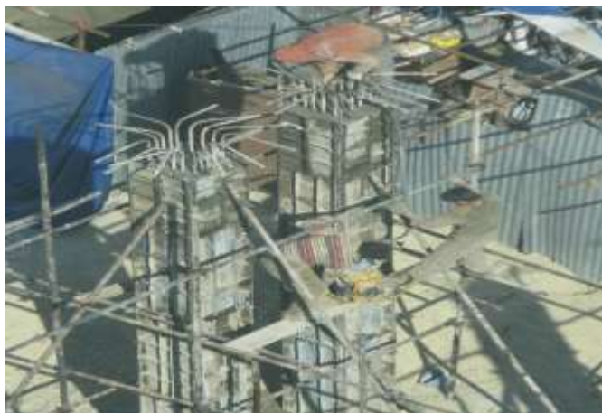
اشکال ۱۵-۴ و ۱۶-۴- عدم استفاده از تجهیزات حفاظت فردی مناسب و ریسک بالای خطرات کار در ارتفاع
