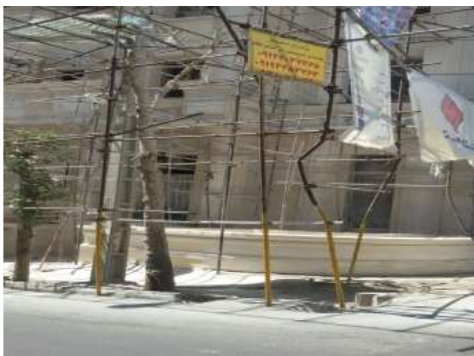
اشکال ۳-۷ و ۳-۸- وضعیت پرخطر داربست ها و زنگ زدگی لقی عدم ایستایی وعدم رعایت فواصله پایه ها و
