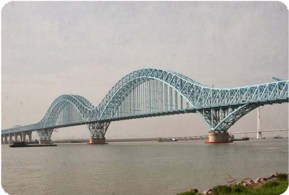
شکل ۱۱-۱۳ پل قوسی خربایی
