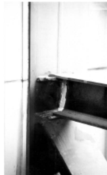
(d) Weld fracture
