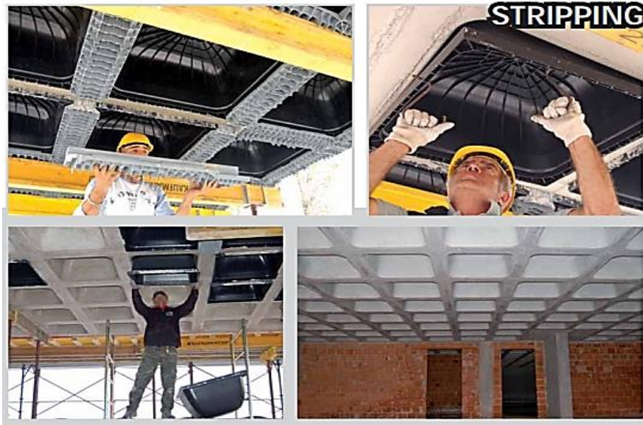
شکل ۱۲. بازکردن قالب ها
