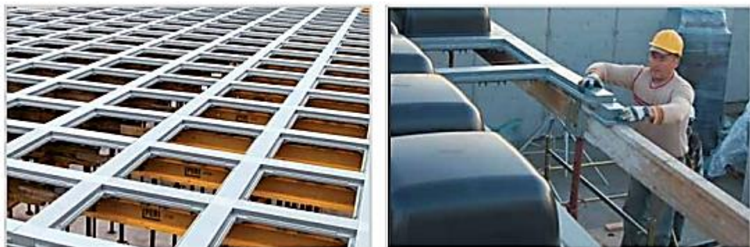
شکل ۸. قالب بندی و کفراژ بندی
