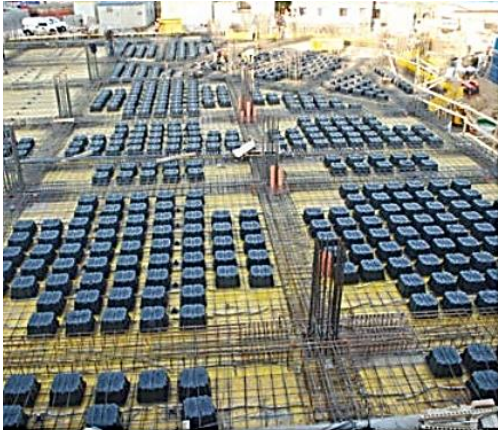
شکل ۳. نمونه ای از مقطع و اجرای دال حبابی (قالب ماندگار)
