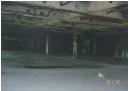
(d) Large deflection in the floor slab
