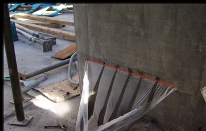
محل اتصال ستون در حال تزریق
