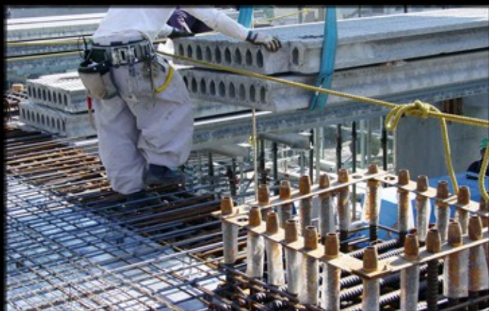
چیدمان قطعات پیش ساخته سقفی
