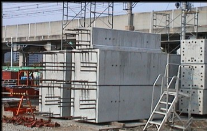
ستونهای پیش ساخته آماده نصب
