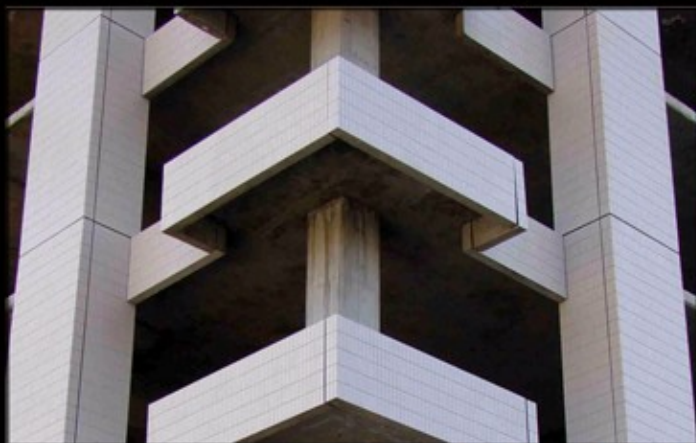
قطعات نصب شده نمای ساختمان به موازات اجرای سازه آن
