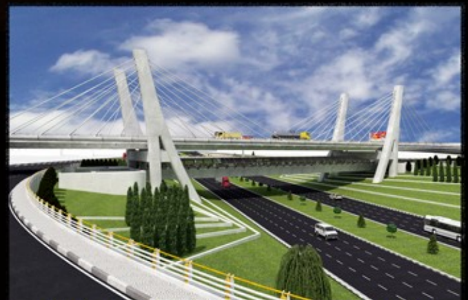
پل کابلی میدان امام حسین (ع) مشهد (در حال ساخت)
