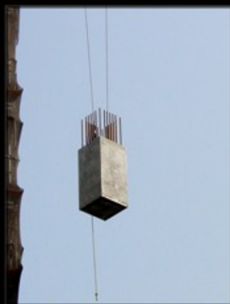
حمل ستون با جرثقیل جهت نصب
