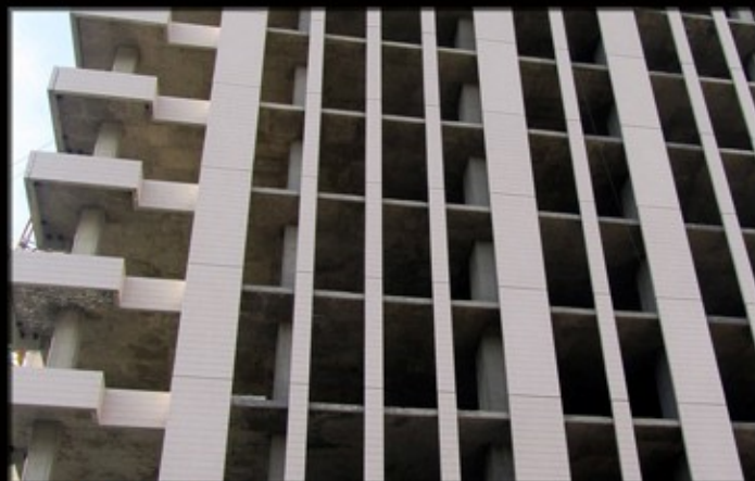
قطعات نصب شده نمای ساختمان به موازات اجرای سازه آن
