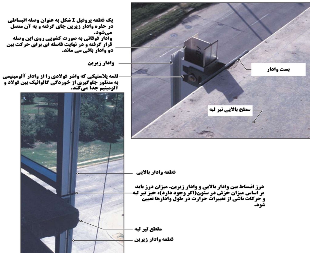
شکل ۸-۸- نمونه اتصال انبساطی بین دو قطعه وادار
