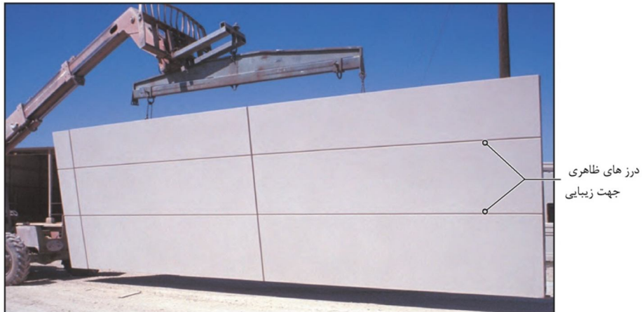
شکل ۶-۳۷ الف - سطح بیرونی یک پانل GFRF، در حال حمل در کارگاه
