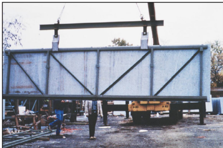
شکل ۴-۲۵- پانل دیواری پرده‌ای پیش‌ساخته سنگی
