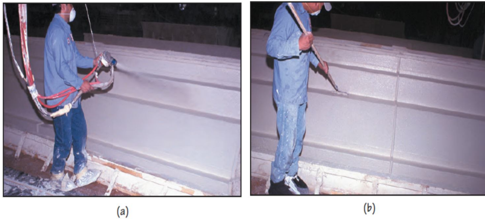
شکل ۶-۴۱-الف) پاشیدن مخلوط GFRC بر روی لایه آستر. (ب) متراکم کردن مخلوط با استفاده از روش غلتک‌زنی در لبه‌ها و گوشه‌های قالب
