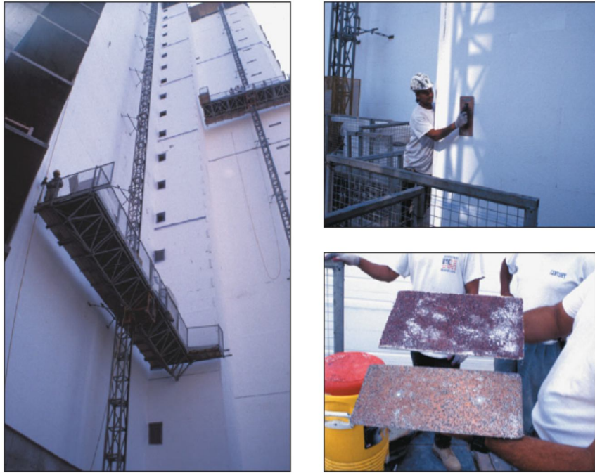
شکل ۶-۱۵- صاف کردن سطح صفحات عایق بعد از چسباندن
