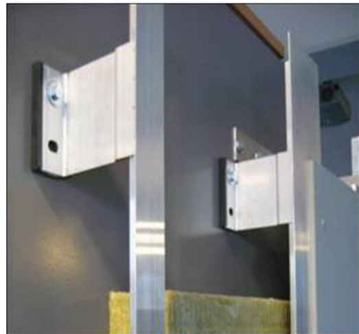
شکل ۶-۴۵- نمونه‌های زیرقاب ساخته‌شده با قطعات آلومینیومی
