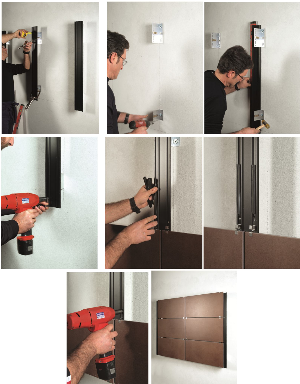
شکل ۷-۲۴- مراحل نصب سیستم نصب نمایان
