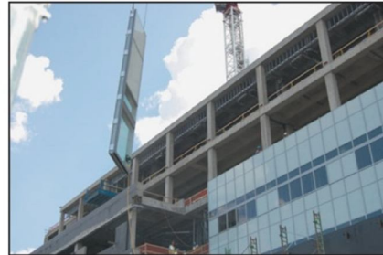
با استفاده از جرثقیل قطعات دیوار پرده ای به محل نصب حمل می شوند
