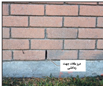
شکل ۵-۱۵- خالی گذاشتن درز ملات جهت زه‌کشی
