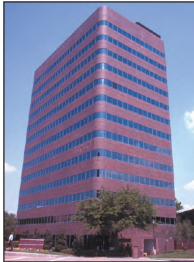
شکل ۵-۲۸- ساختمانی با نما آجری و پنجره‌های پیوسته
