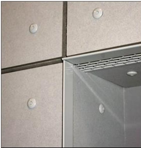
شکل ۶-۶۰- نحوه تأمین مجاری ورود هوا در اجرای نما
