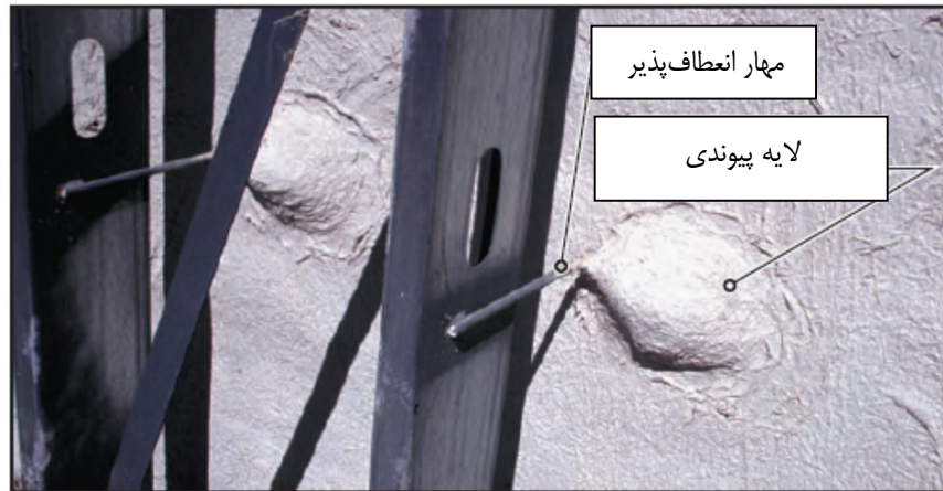
شکل ۶-۳۸ - لایه پیوندی و مهارهای انعطاف‌پذیر
