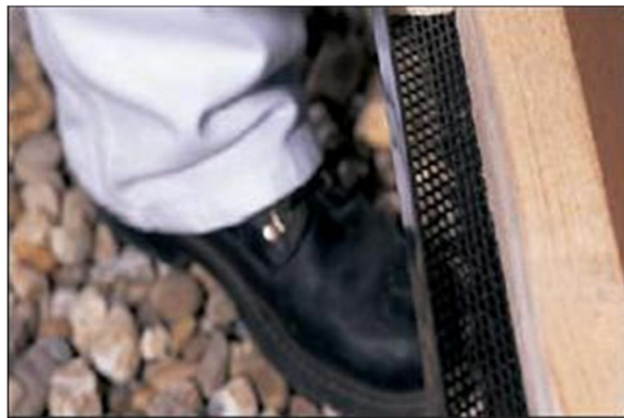
شکل ۶-۶۱- اجرای شبکه توری زیر دیوار
