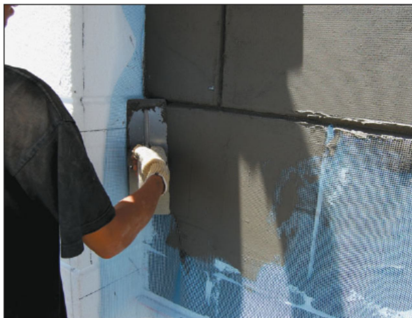
شکل ۶-۱۸- اجرای لایه‌های پوششی
