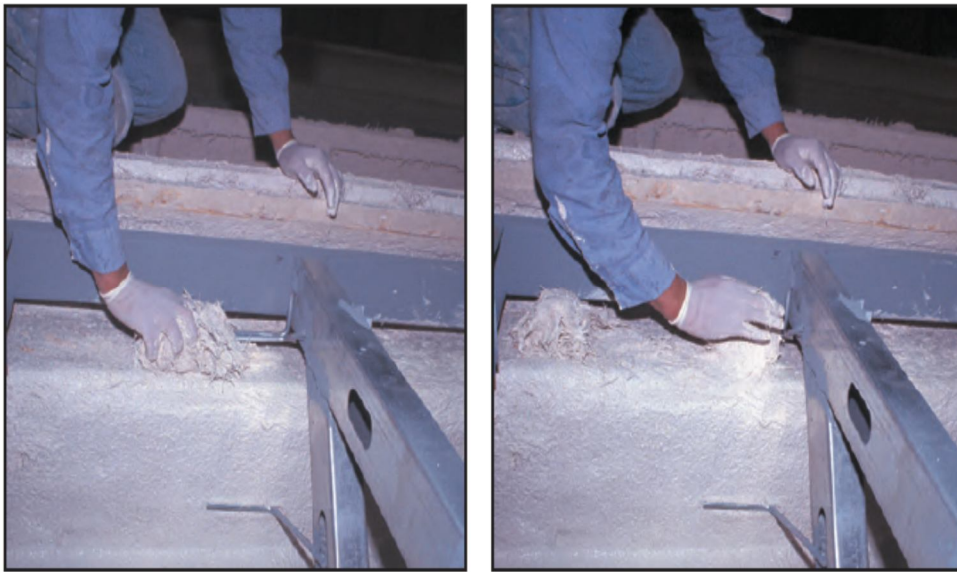
شکل ۶-۴۳- ساختن لایه‌های پیوندی
