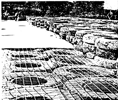
شکل 2-15- نمونه‌های دیوارهای اجرا شده به کمک تایلرهای فرسوده
