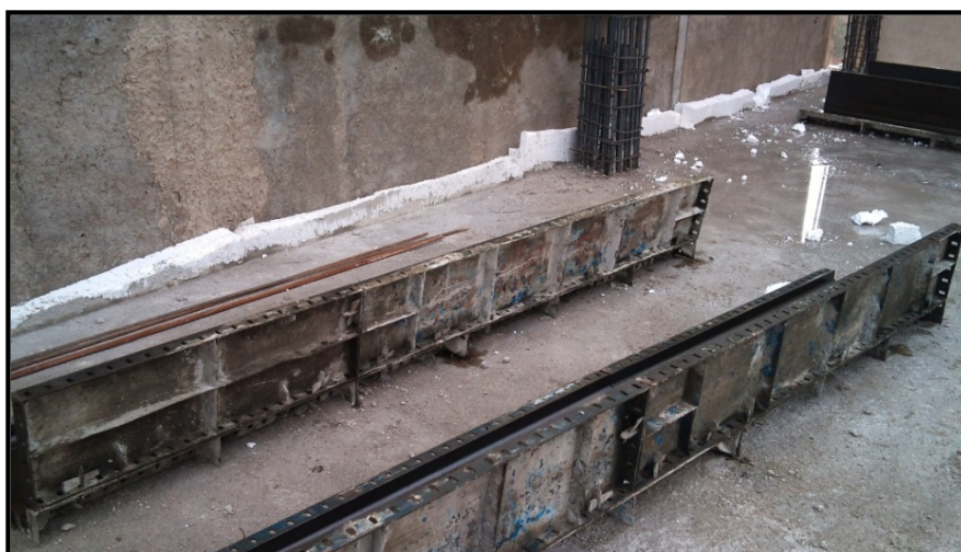
ب (آماده سازی قالب ها)
