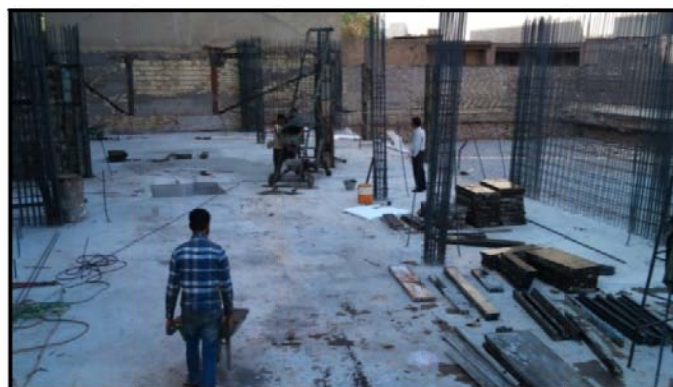
شکل ۴-۵۲) ساخت بتن با میکسر و حمل آن به دستگاه ستون ریز
