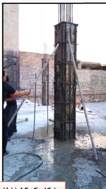
شکل ۴-۵۴ (شاغول کردن ستون پس از اتمام بتن ریزی)
