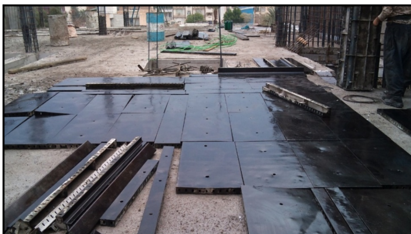
الف (آغشته نمودن قالب ها به ترکیبی از روغن سوخته و گازوئیل)
