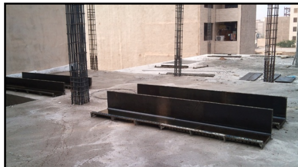
شکل ۴-۴۵ (قالب فلزی ستون)
