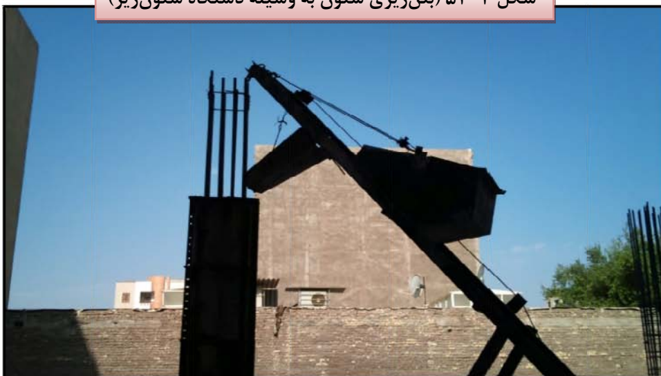
شکل ۴-۵۳ (بتن ریزی ستون به وسیله دستگاه ستون ریز)
