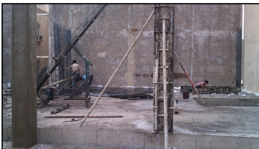
ج (قالب بندی ستون پس از بتن ریزی)
