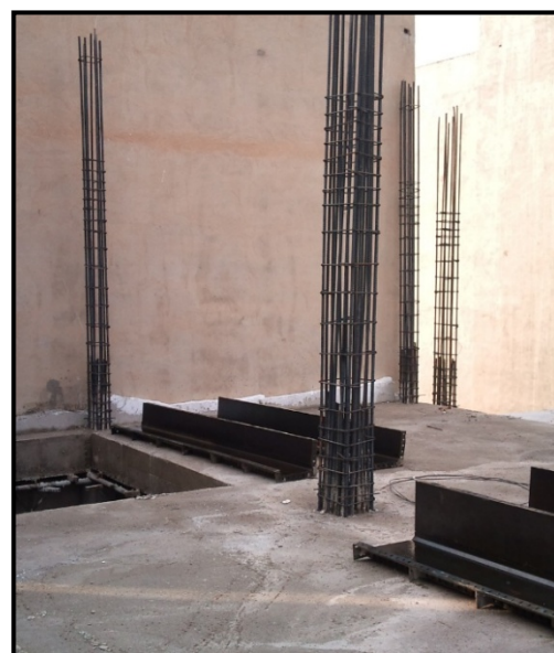
شکل ۴-۴۶ (قالب فلزی ستون)
