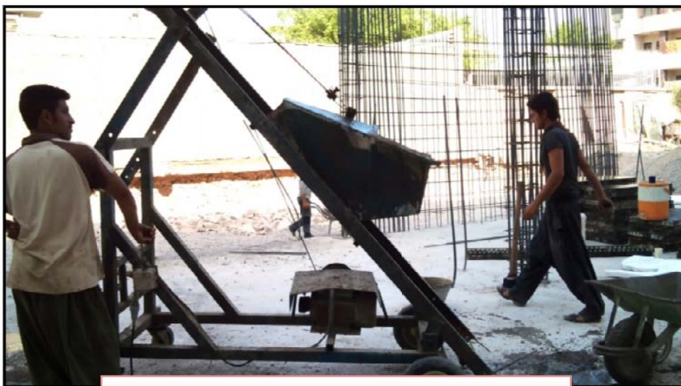
شکل ۴-۵۳ (بتن ریزی ستون به وسیله دستگاه ستون ریز)
