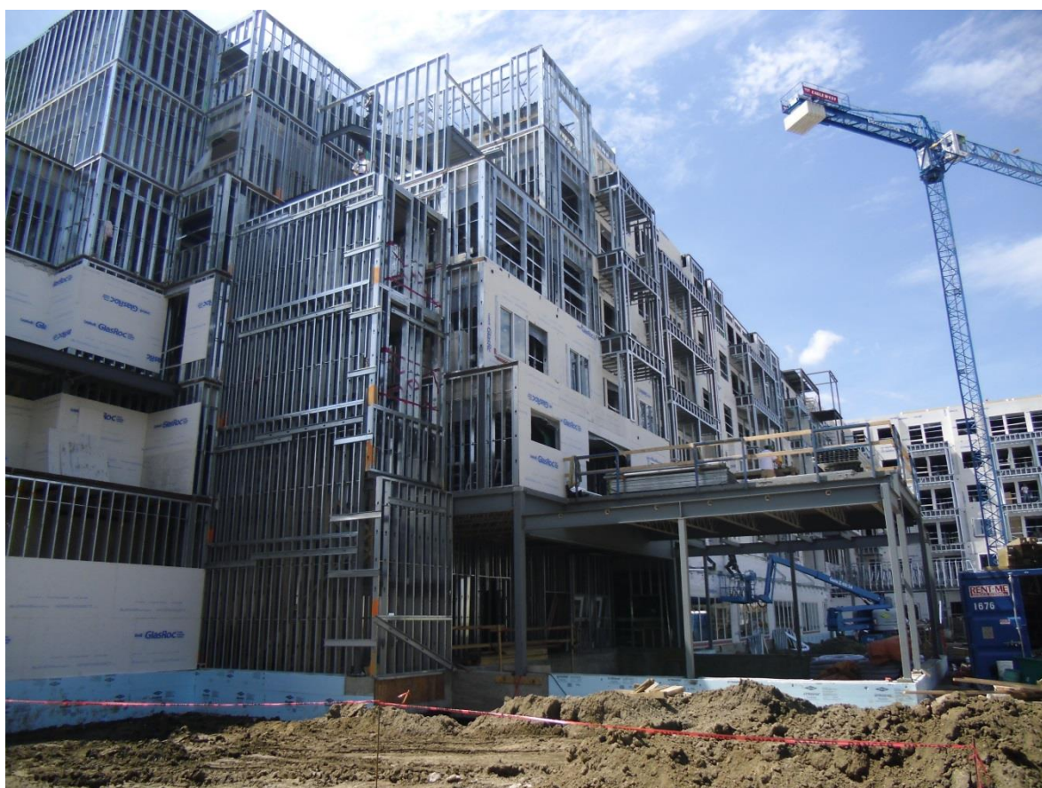
شکل (۱-۱) نمونه ای از ساختمان سازی با سیستم Isf
