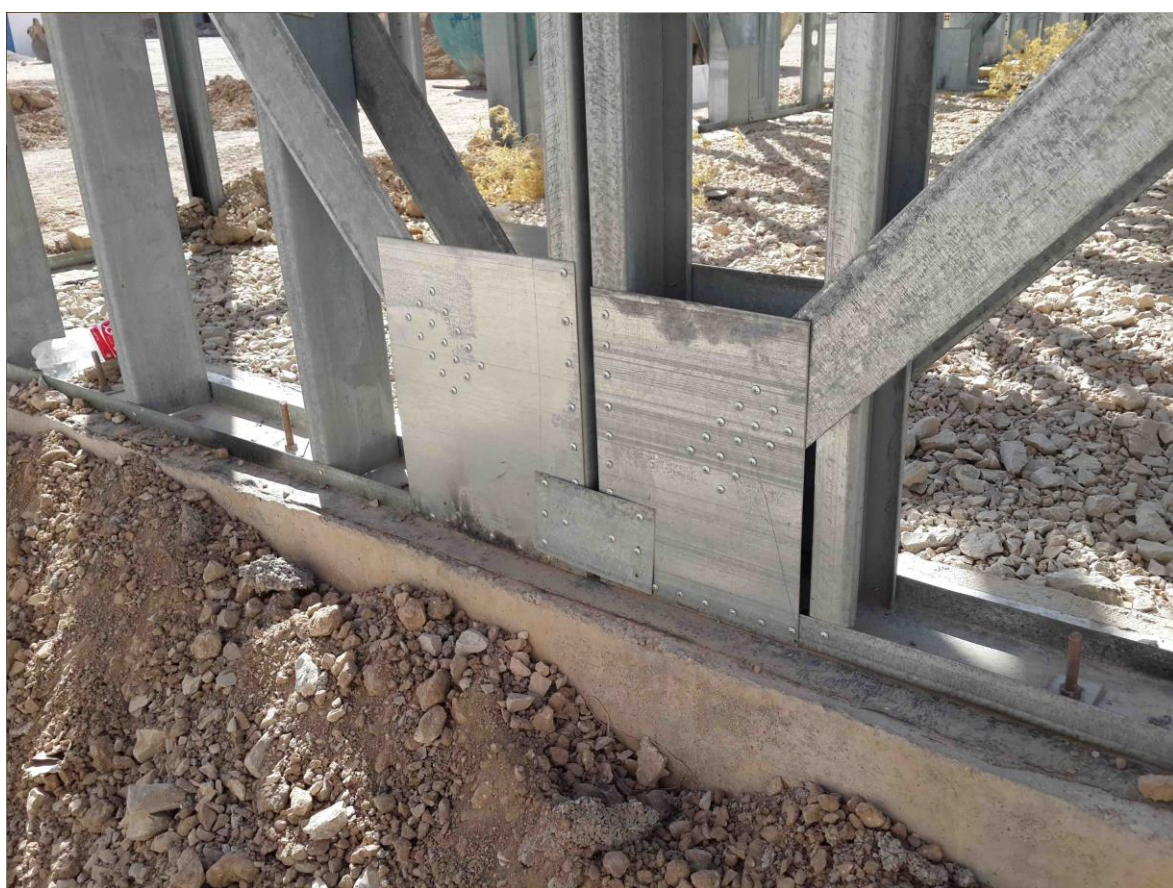
شکل (۱۷-۲) نمایی از اتصال سازه به فونداسیون
