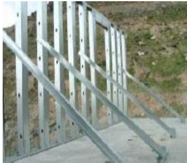
شکل (۲-۱۸) نصب کردن استادها و رانرها
