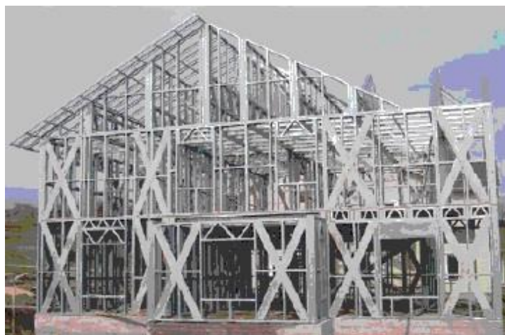
شکل (۳۴-۲) سیستم (LSF) مهاربندی جانبی با بادبند ضربدری
