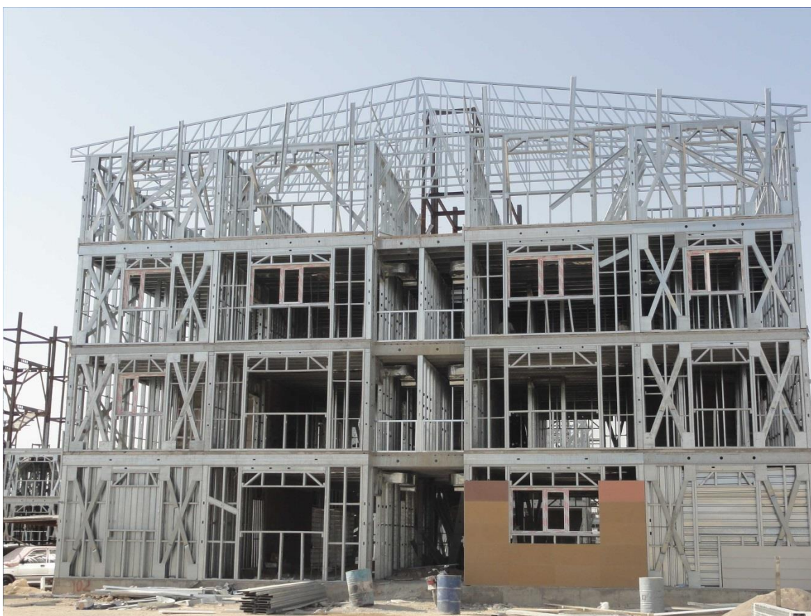
شکل (۲-۲) نمونه ساختمان سازی با سیستم Isf
