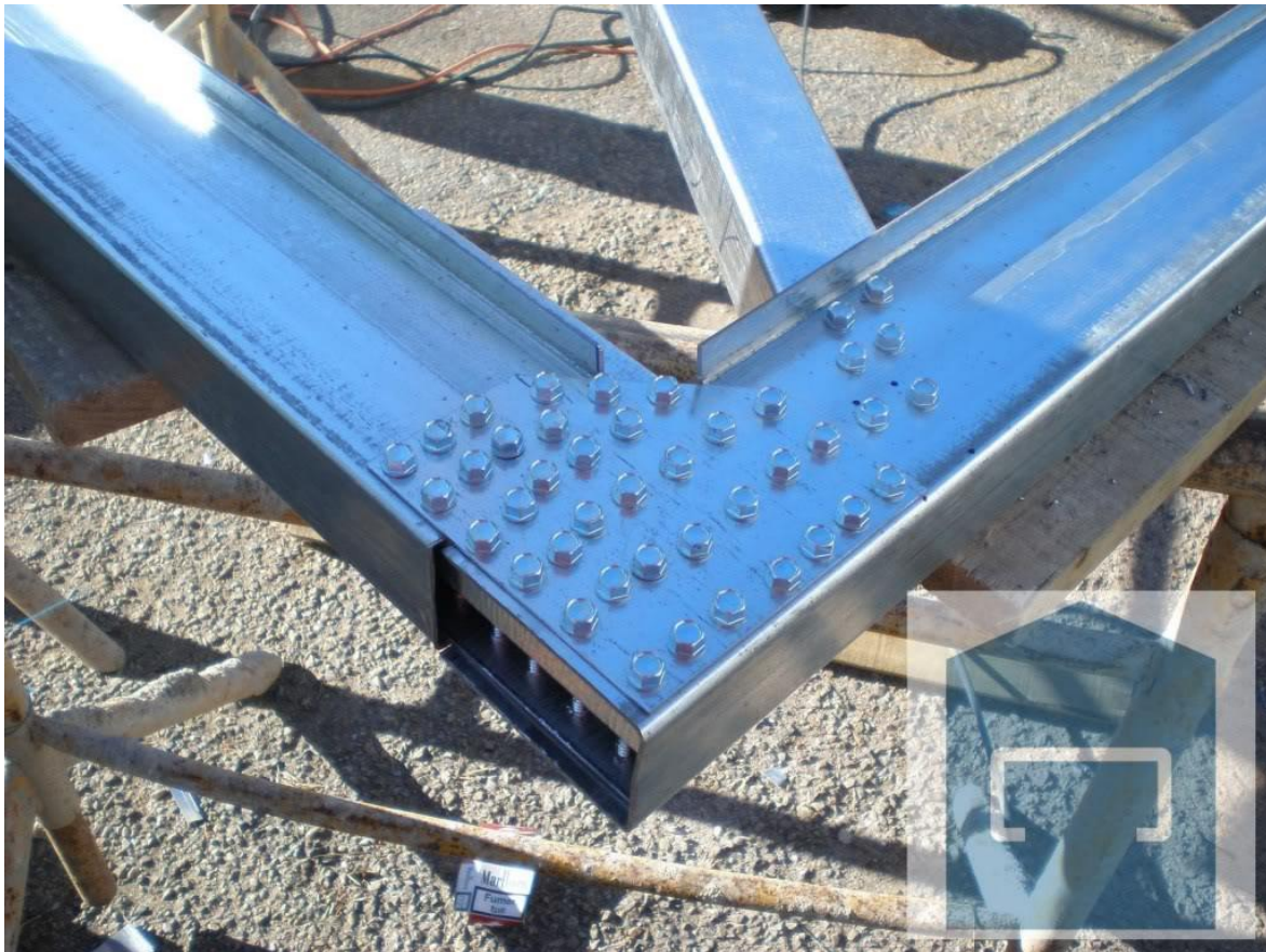
شكل (۲-۱۰) اتصال پیچی قطعات
