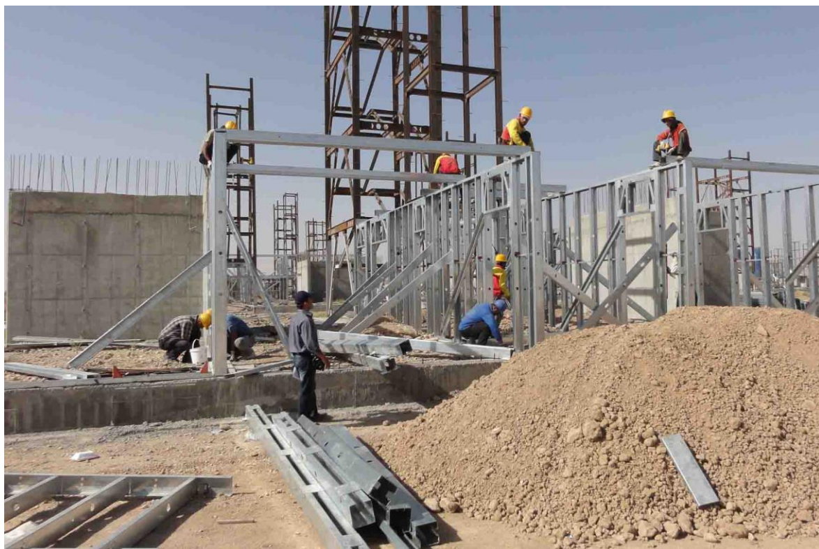
شکل (۱۹-۲) نصب دیوارها
