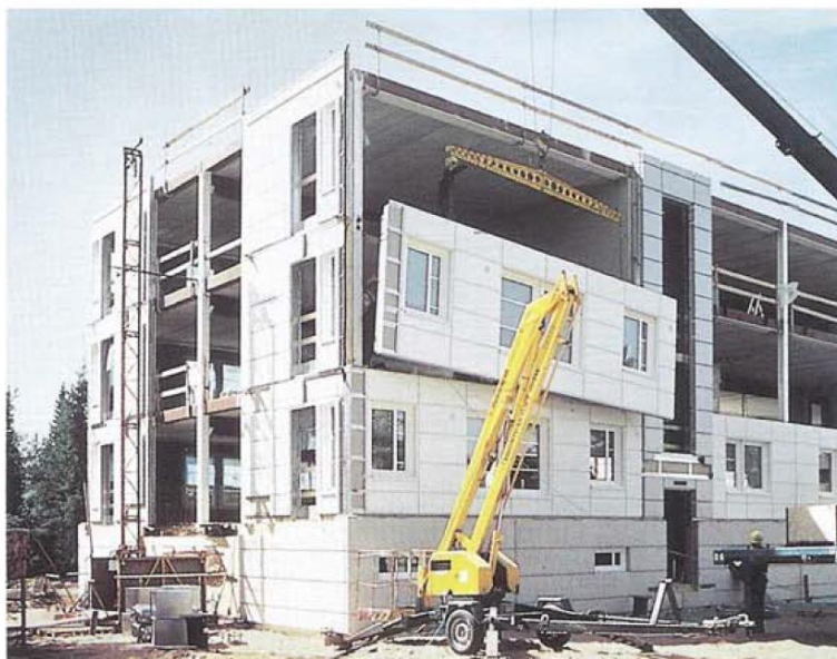
شکل (۲-۱۳) نصب قطعات پیش ساخته
