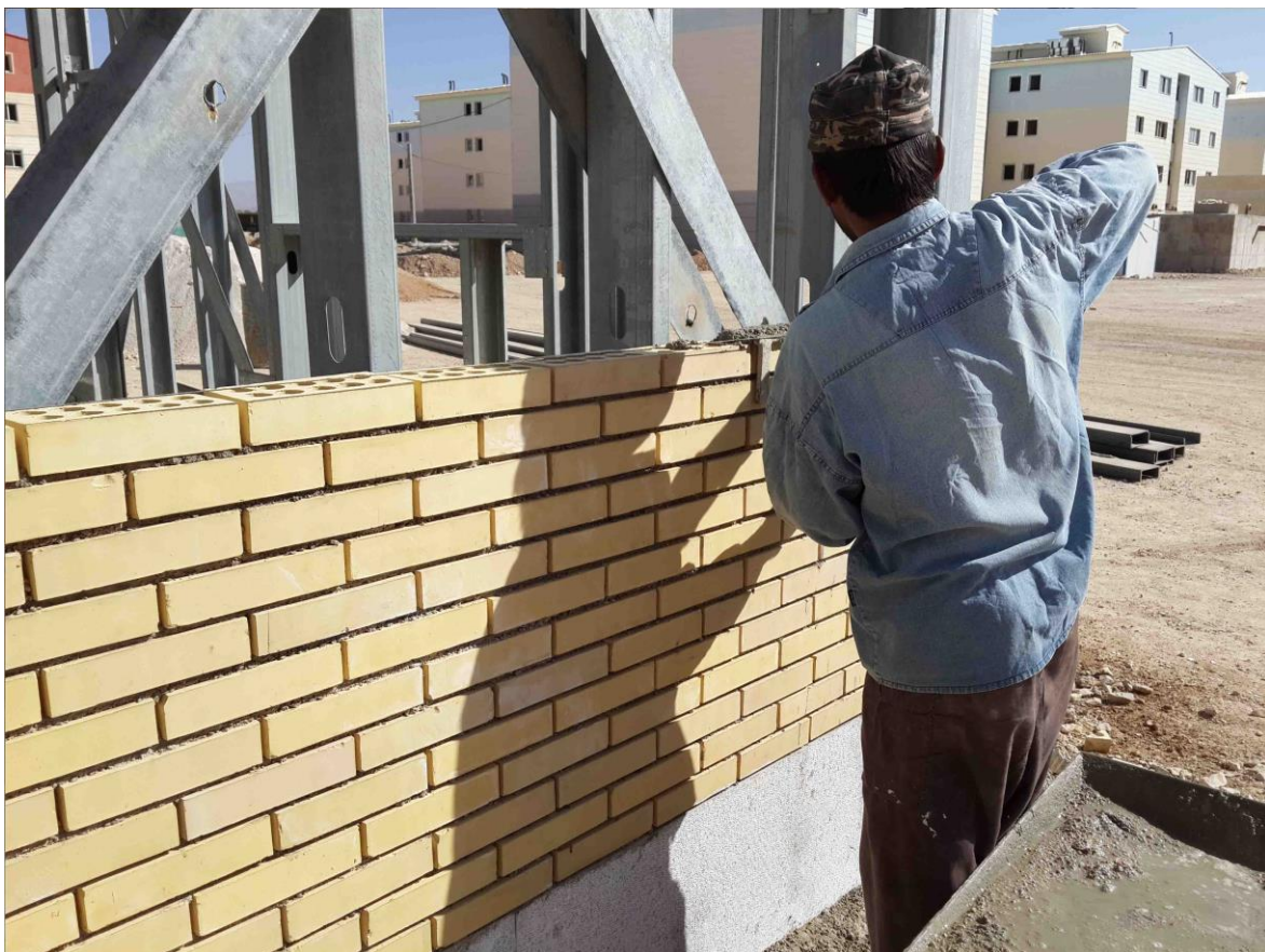
شکل (۲۷-۲) آجرکاری برای نماسازی ساختمان Isf
