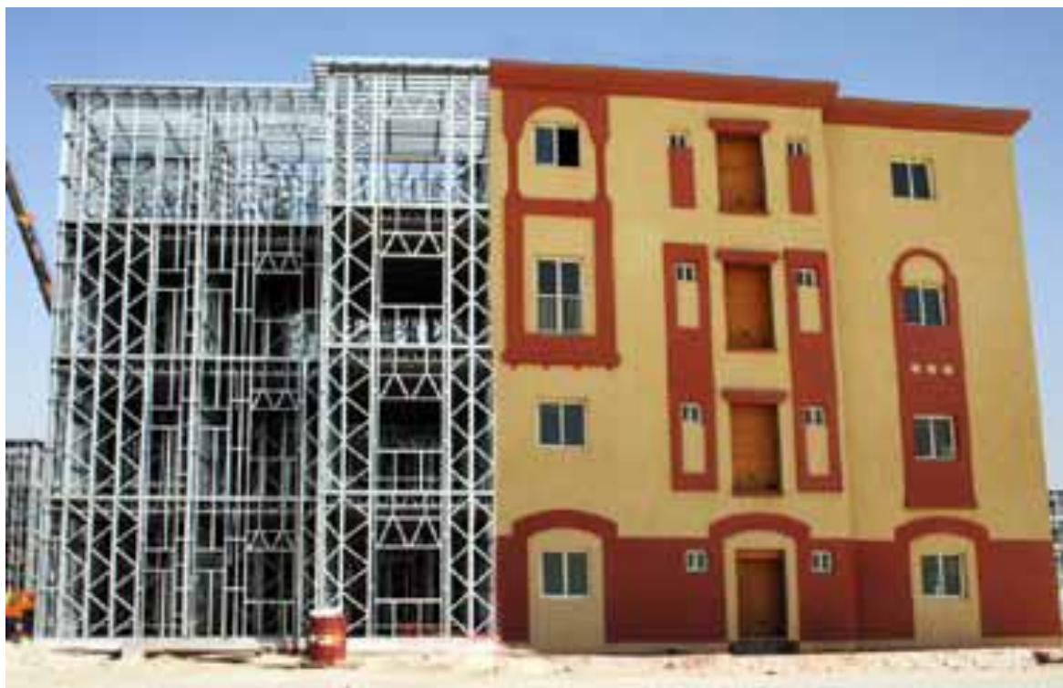
شکل (۱-۲) نمونه ای از ساختمان سازی با سیستم Isf
