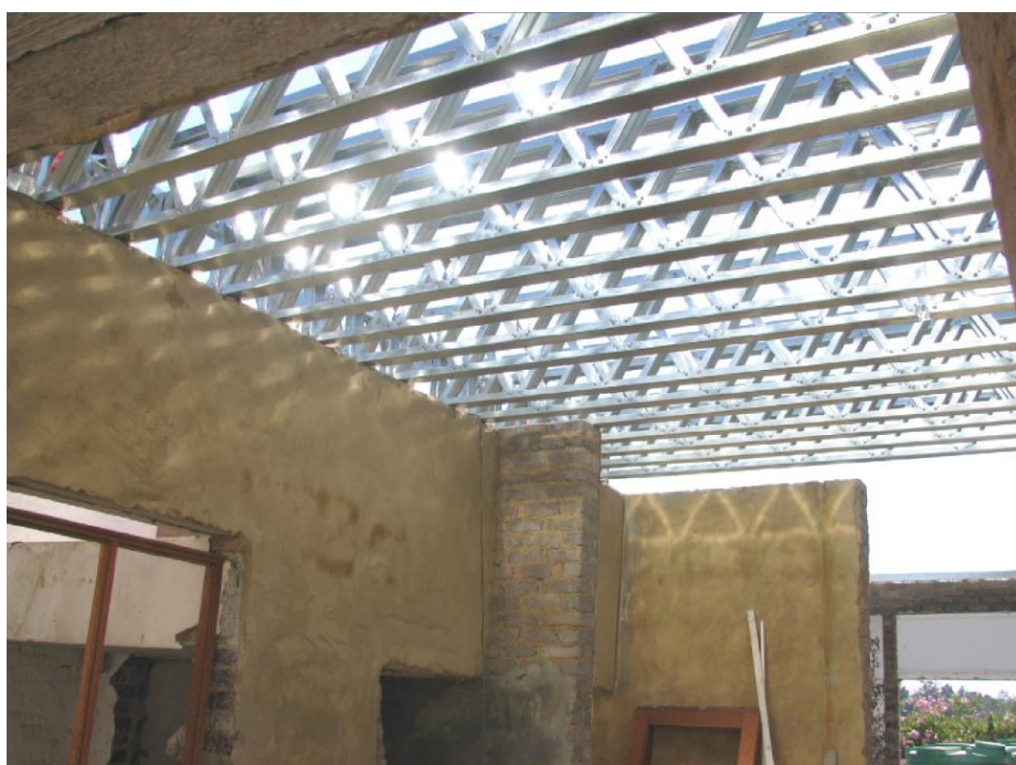
شکل (۲-۲۳) نمایی از سقف در سیستم lsf
