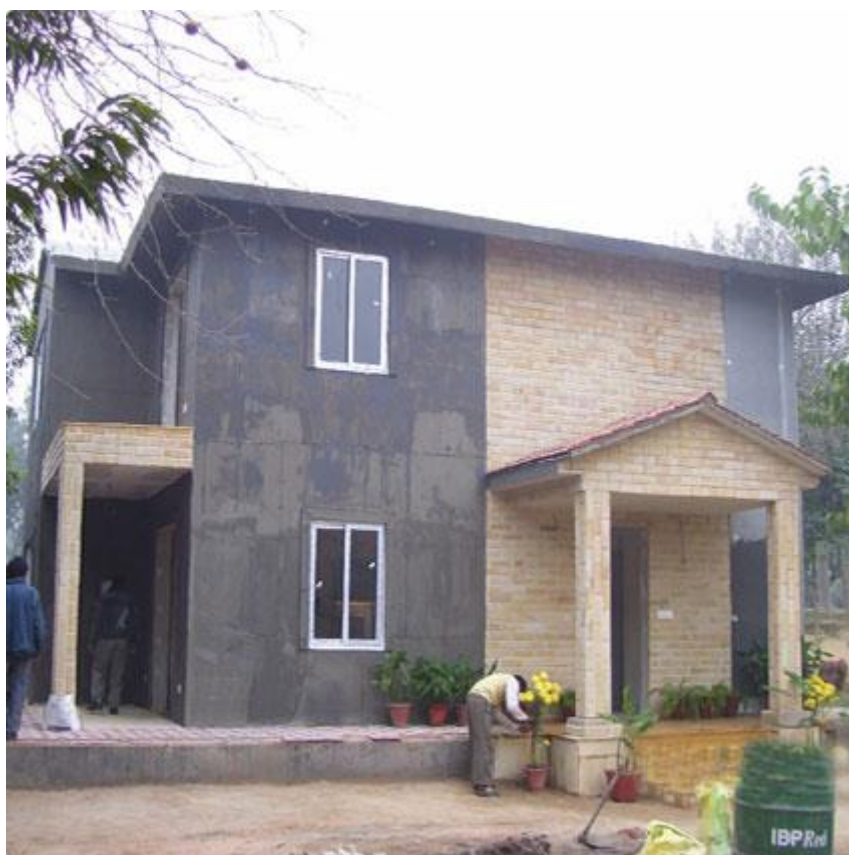
شکل (۲۰-۲) نمونه ای ساختمان با سیستم Isf
