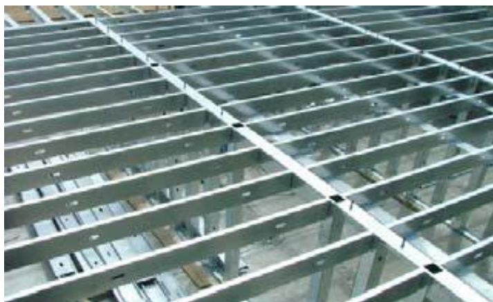
شکل (۲-۲۲) تیرچه ها در سقف
