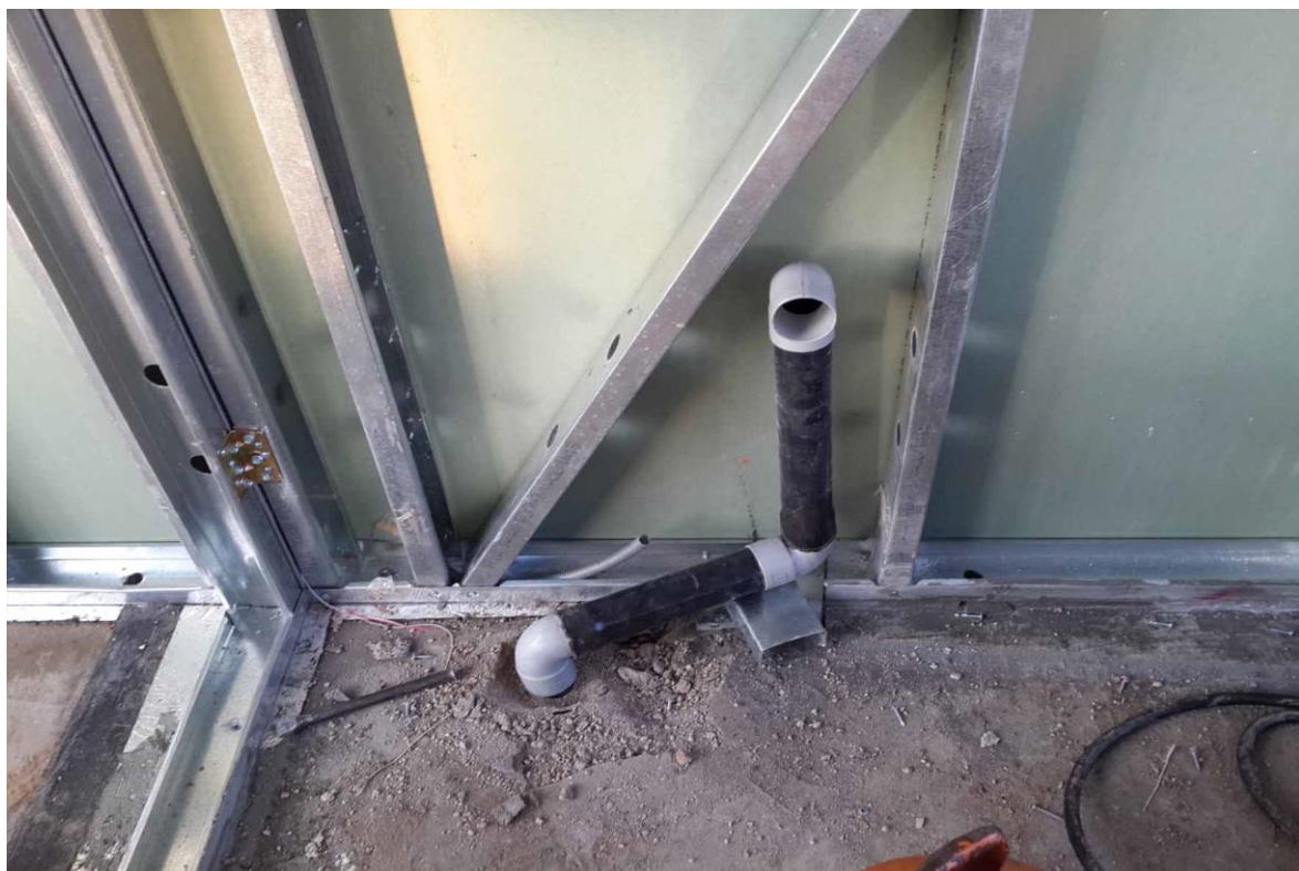
شکل (۲-۳۰) کارگذاری لوله های تاسیساتی
