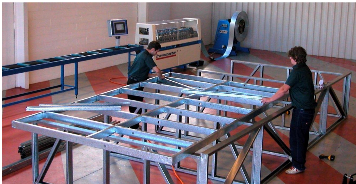
شکل (۲-۵) نمایی از کارگاه ساخت قطعات سازه سیستم ساختمانی Isf
