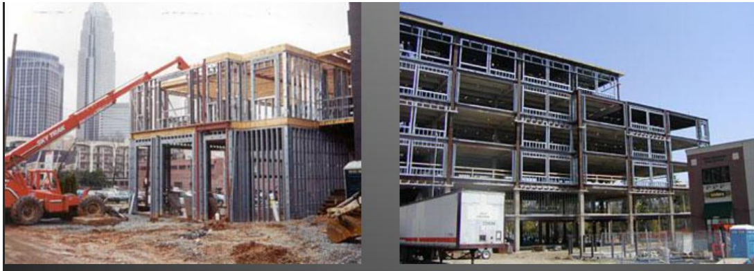
شکل (۲-۳) ساختمان سازی با lsf
