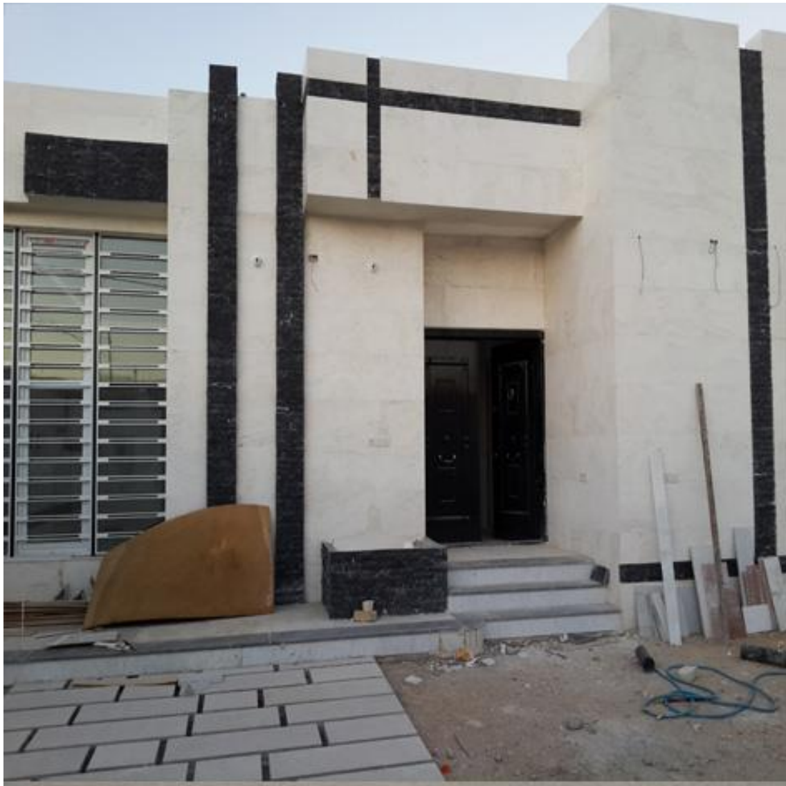
شكل (۲-۲۵) نما سازی با مصالح سنتی برای ساختمان Isf
