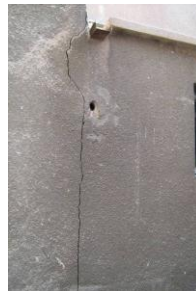
وجود ترک در دیوارها و سقف
