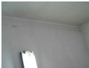
وجود ترک در دیوارها و سقف
