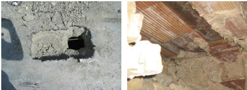
عملیات سونداز سقف ساختمان
