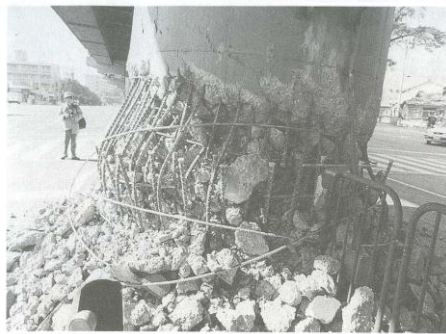
شکست وصله های جوشی (مفصل خمشی) پای ستون زلزله ۱۹۹۵ کوبه
