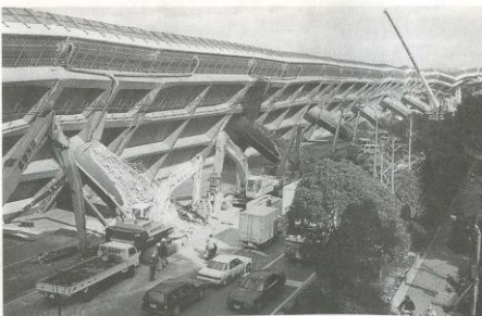
شکست خمشی ستونهای پل بزرگراه هانشین زلزله ۱۹۹۵ کوبه
