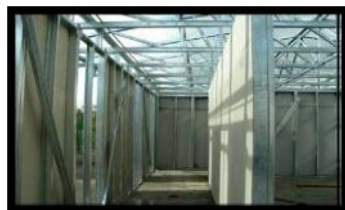
شکل (۲) اتصال استاد و رانر برای نصب پانل
