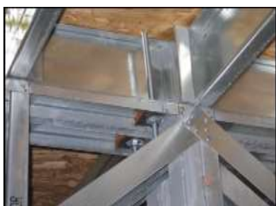
شکل ۱۱- اتصالات با استفاده از پیچ های سرمه ای [۵]
