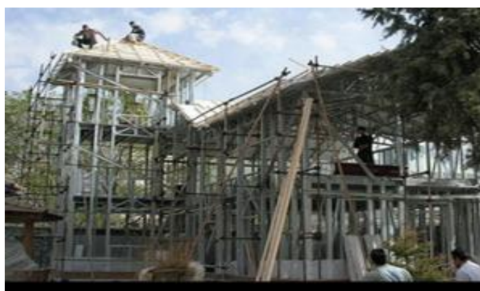
شکل 2: نمونه ای اجرا شده سازه سبک LSF
