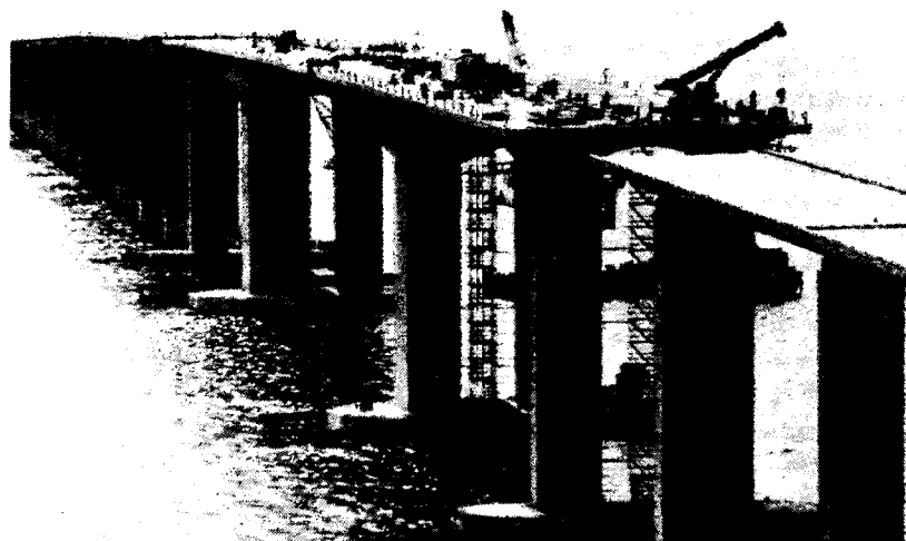
شکل شماره ۱-۶-۱- نمای دور و نزدیک، پل بزرگراه فهد در حال ساخت
