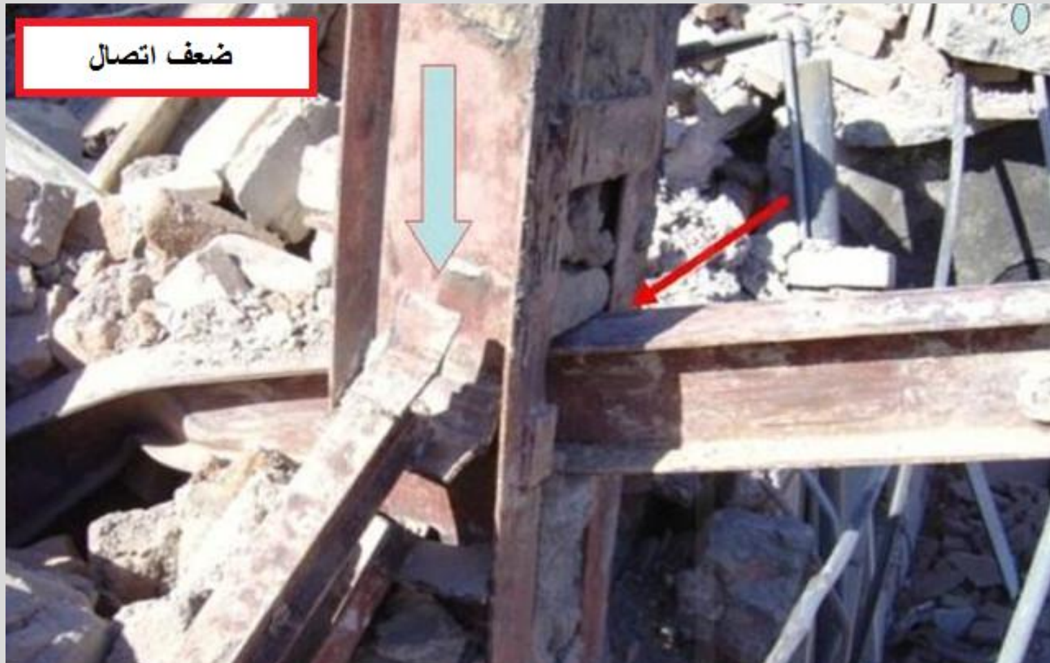
ضعف اتصال تیر به ستون و عبور تیر از بین ستون و بستهای موازی بدون اتصال
