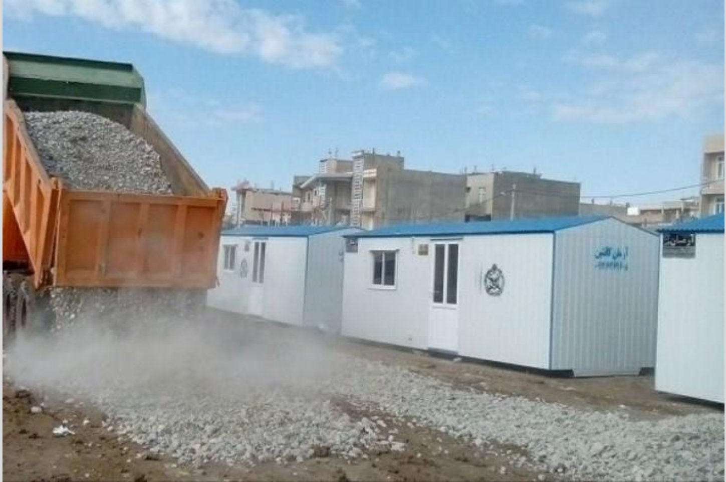
تهیه کانکس جهت اسکان موقت زلزله زدگان
