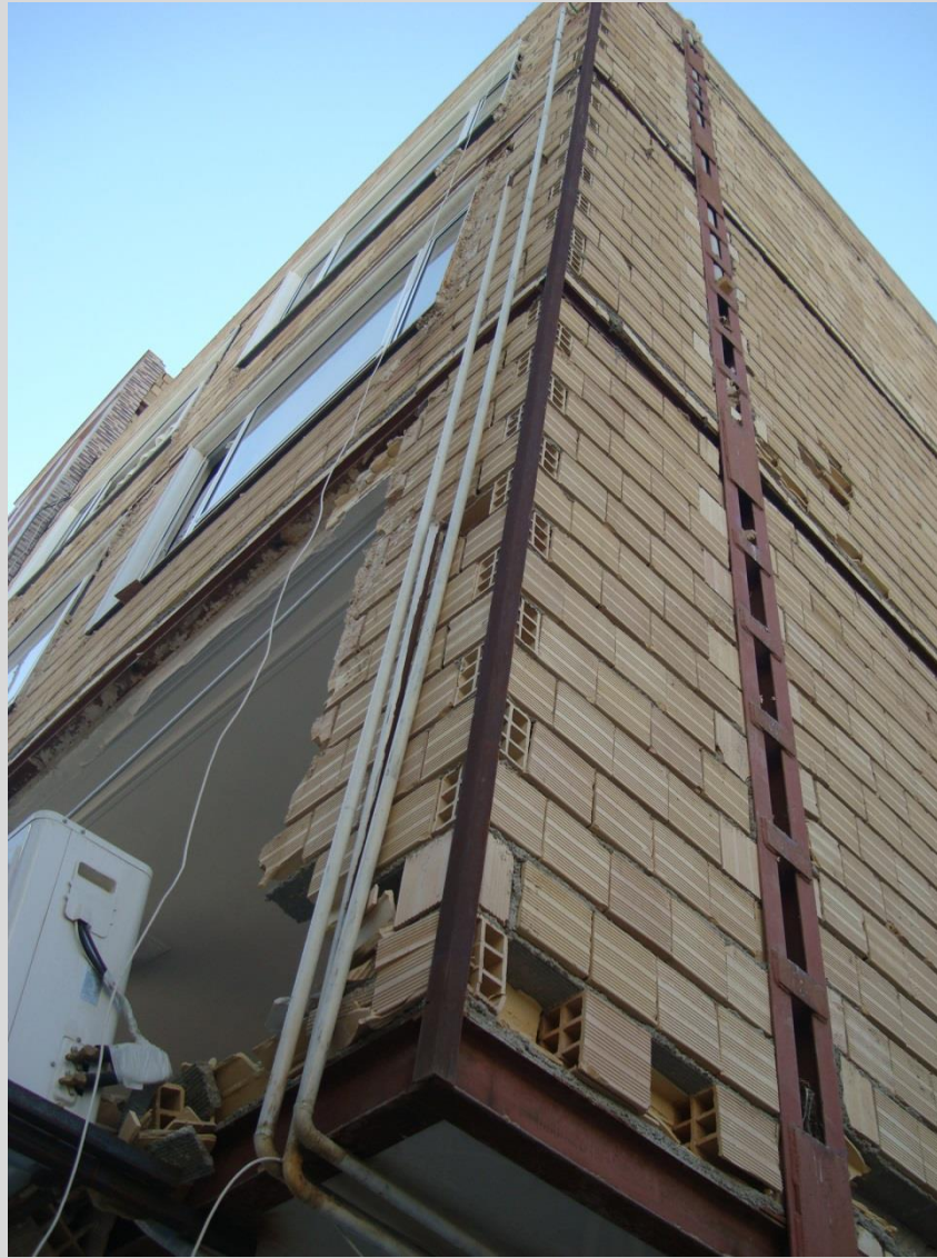
اجرای نبشی کشی ( کلاف بندی) مناسب و پایداری دیوار
