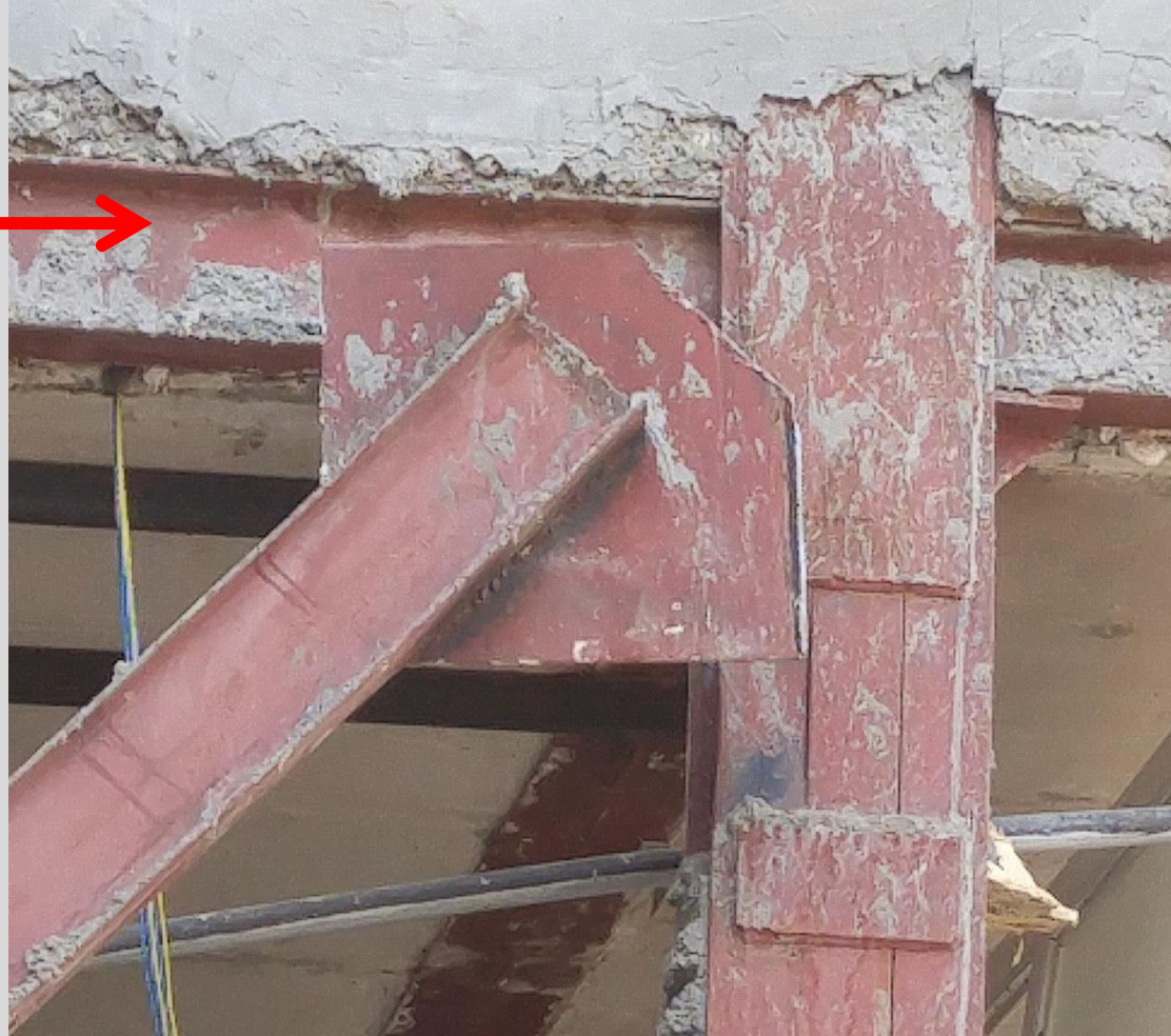
(ضعف اتصال گاست) عدم جوش ورق گاست به تیر
