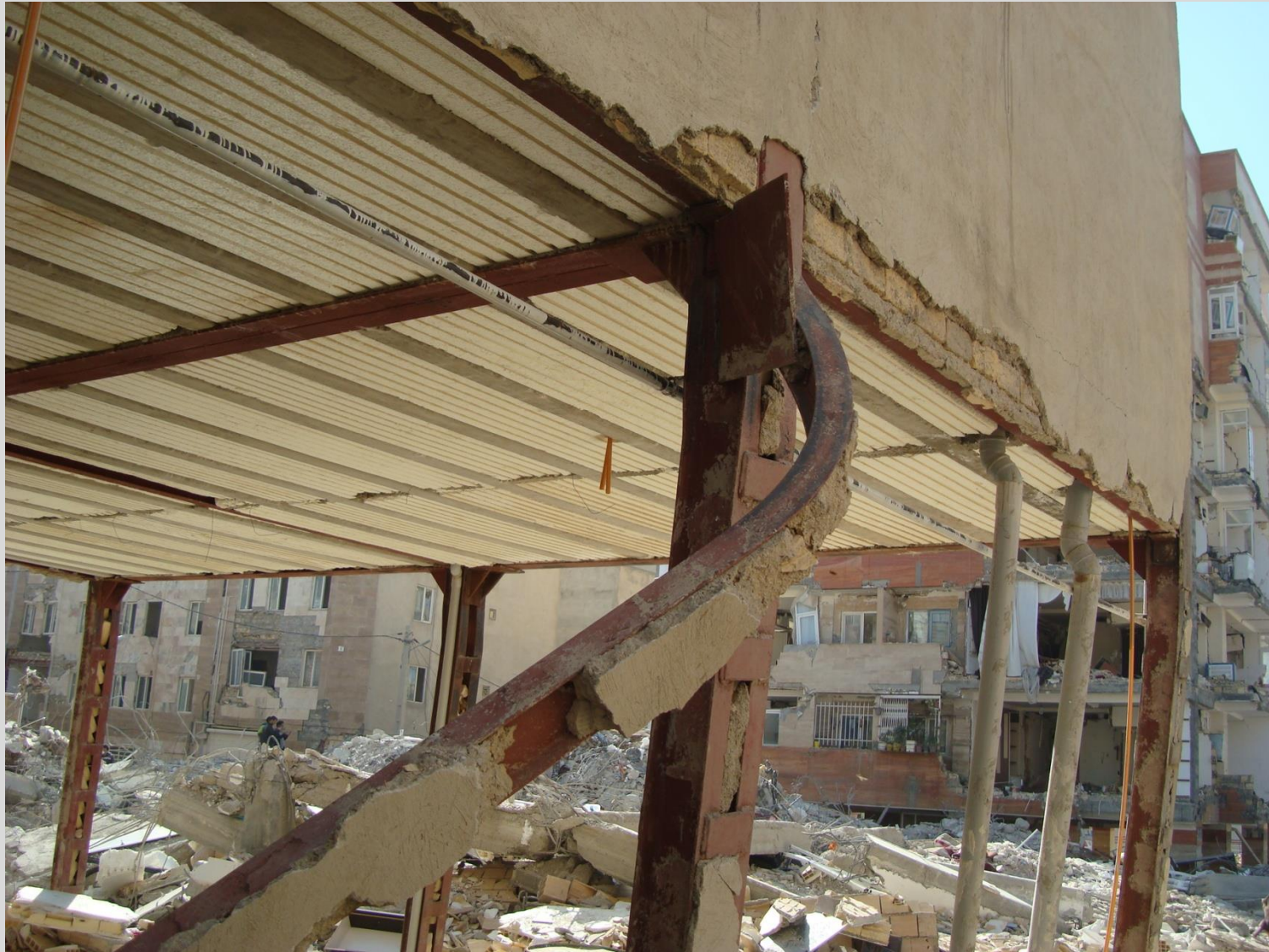
کمانش عضو بادبندی لاغر در فشار حول محور ضعیف ( تک پروفیل IPE )
