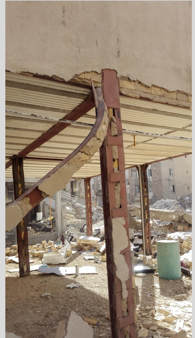
کمانش عضو بادبندی لاغر در فشار حول محور ضعیف ( تک پروفیل IPE )
