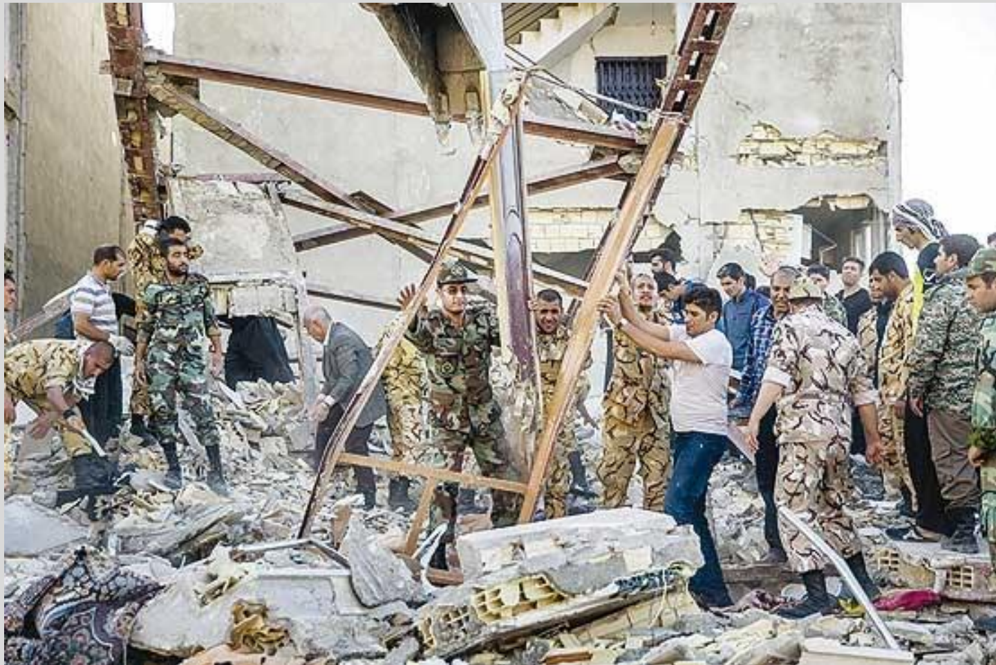
عدم مهار جانبی قاب ساختمانی و فروریزش کامل قاب
