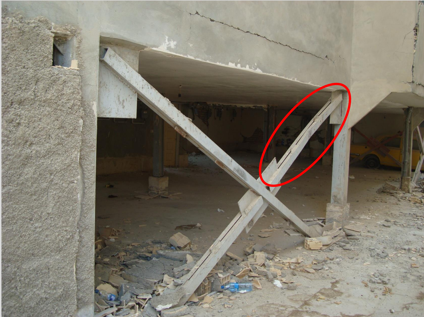
اجرای مناسب ورق گاست و فواصل لقمه‌ها
