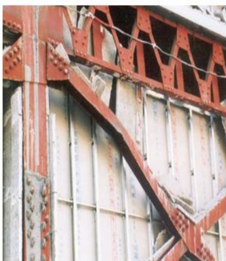
کمانش خارج صفحه (شکل سمت راست) در مقابل کمانش داخل صفحه (شکل سمت چپ) بادبند
