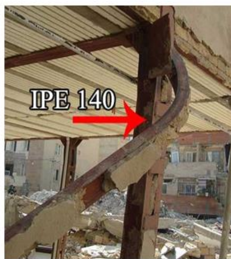
کمانش خارج صفحه (شکل سمت راست) در مقابل کمانش داخل صفحه (شکل سمت چپ) بادبند
