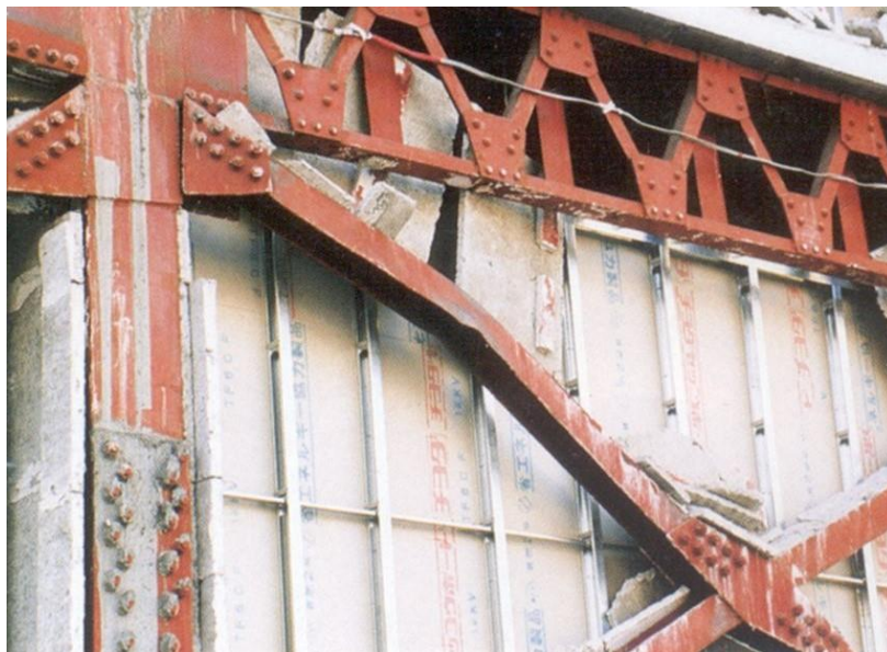
نمونه ای از کمانش داخل صفحه ی مهاربند
