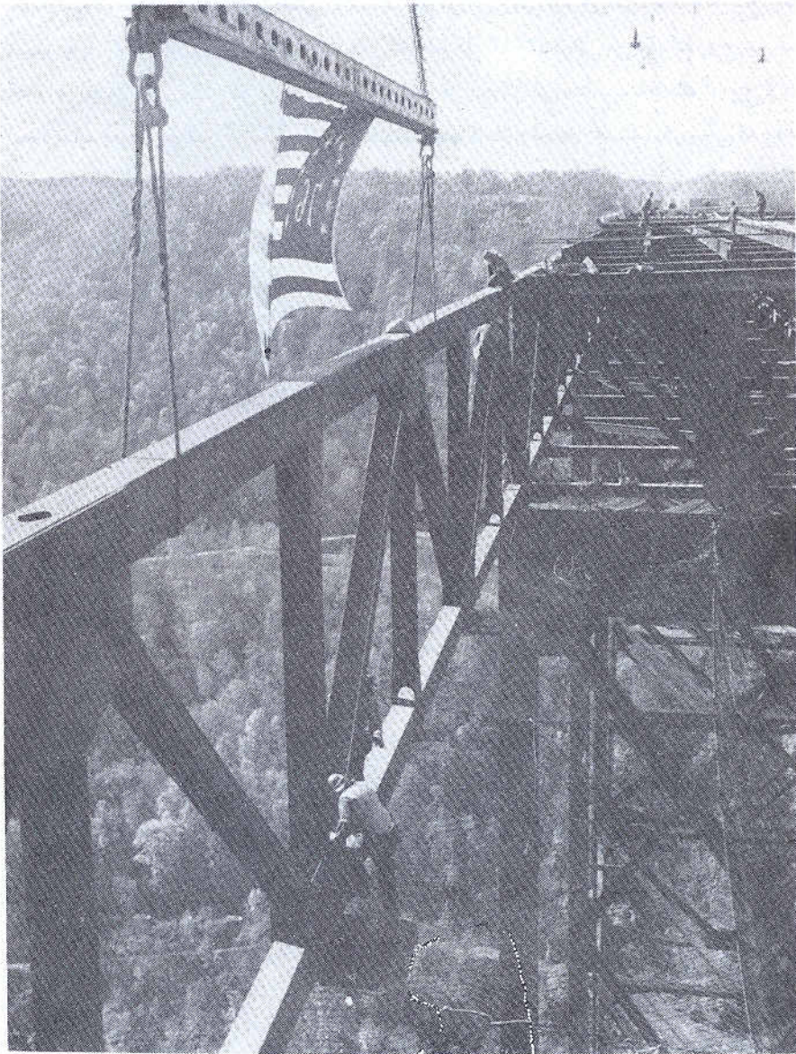
عملیات نصب پل فولادی
